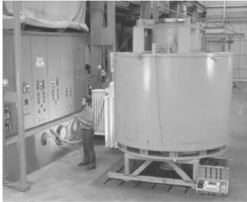
Gambar 5.2 Sebuah motor sinkron tiga fasa besar. Bradley Listrik.
