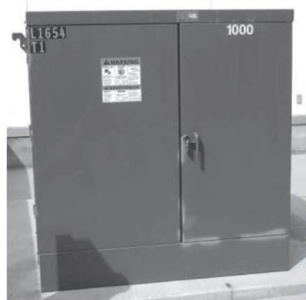
GAMBAR 2-39 Trafo yang dipasang pada bantalan umumnya terdapat dalam lemari besi.
