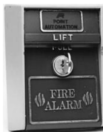
GAMBAR 7-17 Gagang tarik alarm kebakaran.
