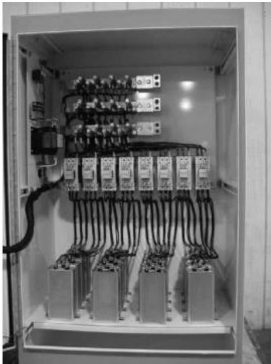
GAMBAR 11-22 Kapasitor yang digunakan untuk koreksi faktor daya.
