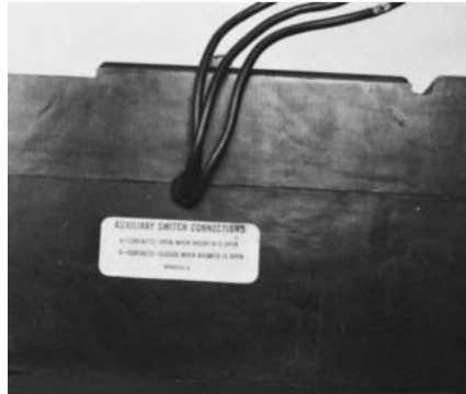
GAMBAR 13-17 Sambungan sakelar bantu.
