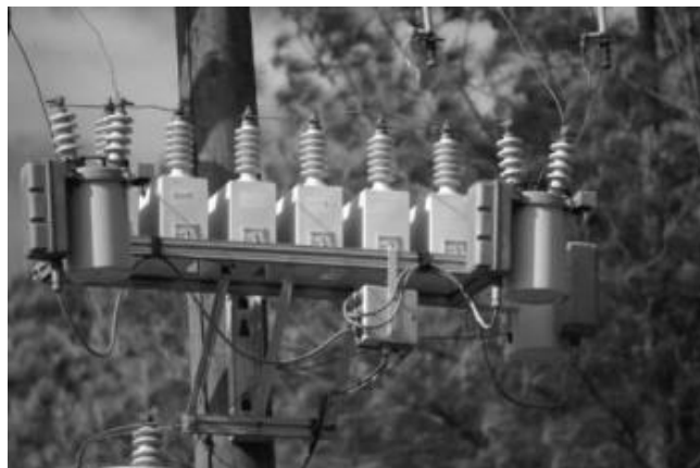
GAMBAR 11-12 Kapasitor yang digunakan untuk koreksi faktor daya.
