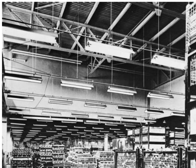
GAMBAR 5-9 Sistem penerangan busway troli tipikal.
