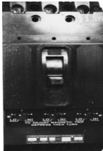
GAMBAR 13-7 Pemutus sirkuit magnetik tiga kutub.
