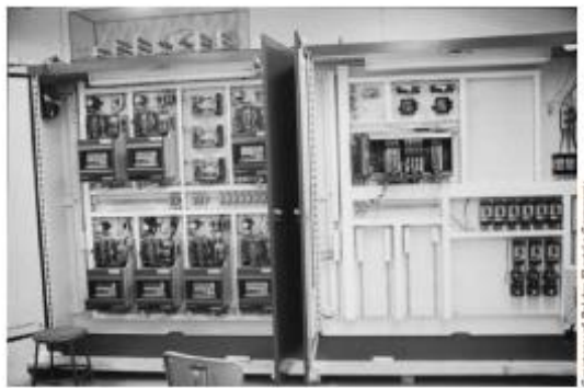
GAMBAR 16-18 Unit penggerak arus searah yang dikendalikan oleh PLC.
