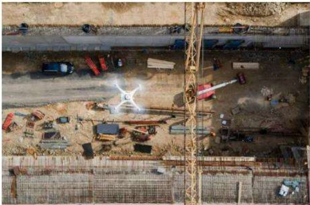
Gambar 2.11 Gambar yang diambil oleh drone ketika memantau progress konstruksi.
