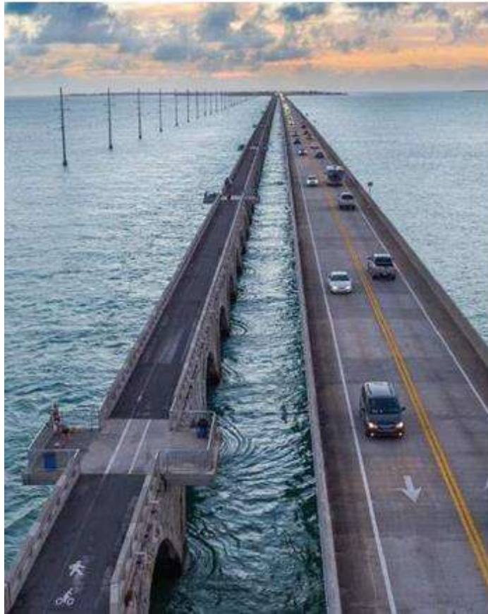
Gambar 5.8 Pemandangan dua buah jalan jembatan memanjang membelah laut, komposisi yang pas dengan mode triangle technik membuat gambar dibagian ujung menjadi sangat sempit dan terkesan jalannya menjadi sangat jauh dan bagian terdekat dari kamera menjadi lebih lebar.
