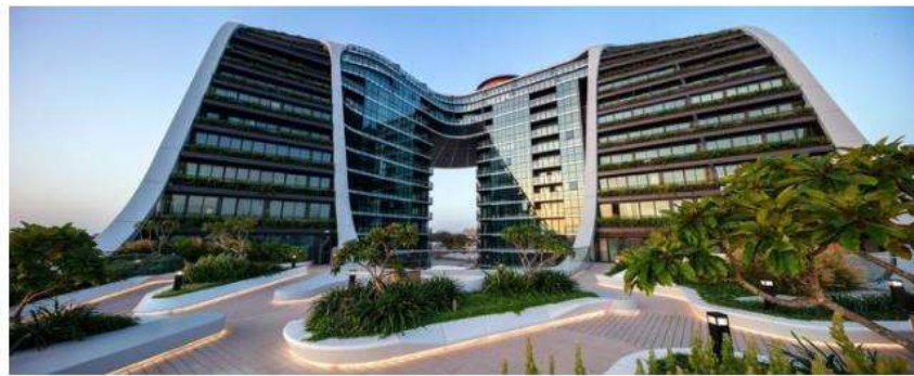
Gambar 5.47 Gedung ini masih sama dengan gedung sebelumnya, cahaya sore yang indah memantul diantara kaca, dan sebagian tertutup gedung dan memberikan efek bayangan sedikit gelap, memberikan suasana yang cukup indah di sore hari.
