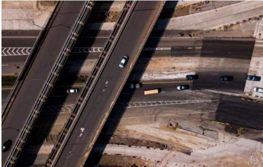
Gambar 5.24 Pola tak beraturan terbentuk di proyek jalan tol Banyuwangi
