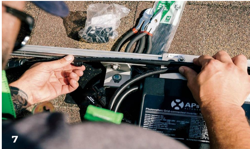
Gambar 6.25 Mengencangkan kabel rel dengan klip kabel
