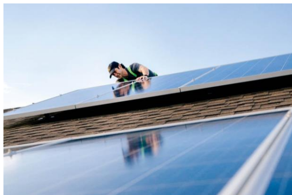
Gambar 4.4 Pemasangan sistem PV
