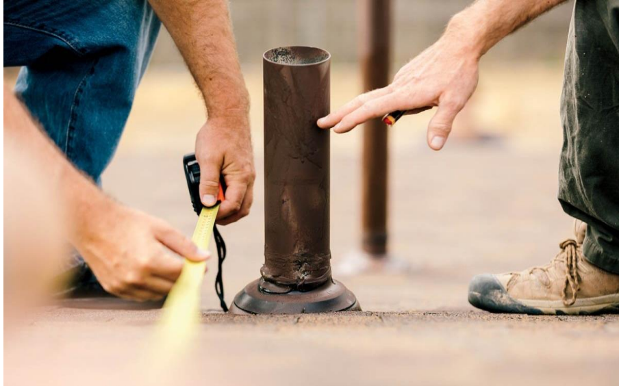
Gambar 1.18 Pengeboran Tiang untuk Pemasangan
