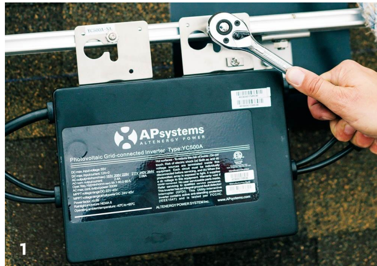
Gambar 6.19 Pemasangan mikro inverter ke rel
