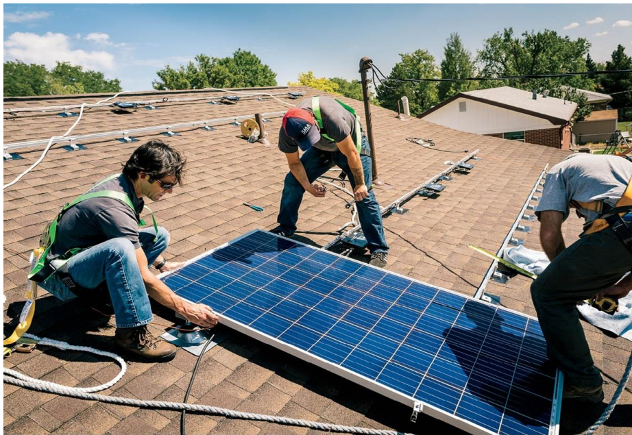
Gambar 6.28 Proses penginstalan modul pertama ke rel
