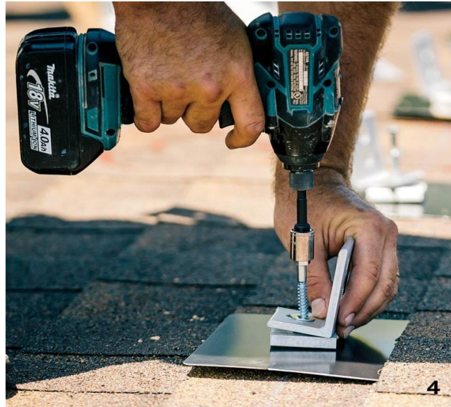
Gambar 6.12 Pemasangan footer
