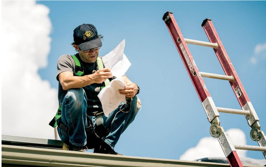
Gambar 4.10 kru yang sedang melihat konsep pemasangan modul PV
