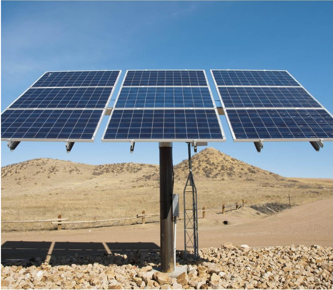
Gambar 3.15 Pemasangan tiang tunggal
