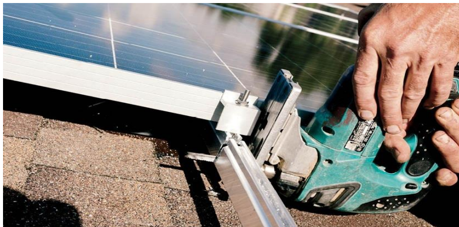
Gambar 6.32 Pemasangan modul yang tersisa
