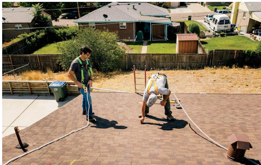
Gambar 6.1 Kegiatan proses pemasangan di atap
