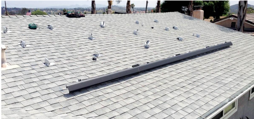
Gambar 3.8 Pemasangan di atap dan skirting dipasang untuk sistem pemasangan tanpa rel. Skirting bersifat opsional dan memberikan tampilan akhir ke bagian larik yang paling terlihat.
