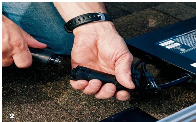
Gambar 6.20 Menghubungkan setiap mikroinverter dengan konekter
