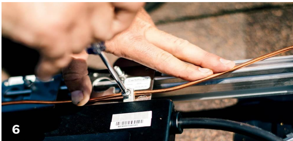
Gambar 6.24 Hubungkan kabel arde ke tiap kotak mikroinverter
