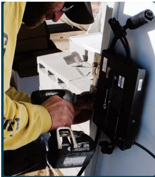
Gambar 6.18 Pemasangan bingkai mikroinverter
