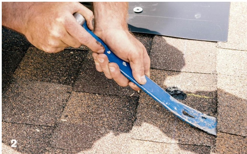
Gambar 6.10 Pemecahan segel sirap aspal
