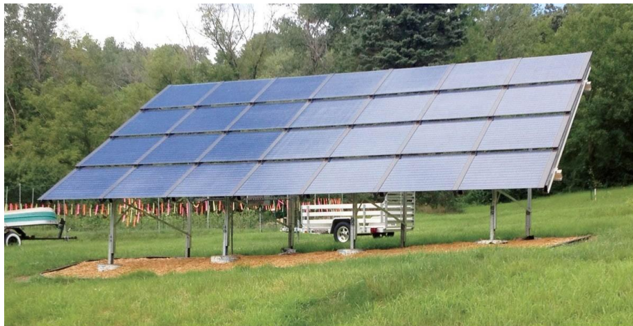
Gambar 1.19 Ground-mount dapat ditempatkan dan diposisikan untuk paparan sinar matahari yang optimal.
