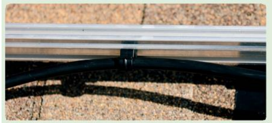
Gambar 6.35 Klip rel (biasanya dipasang oleh rak atau pabrikan mikroinverter) kencangkan langsung ke rel.
