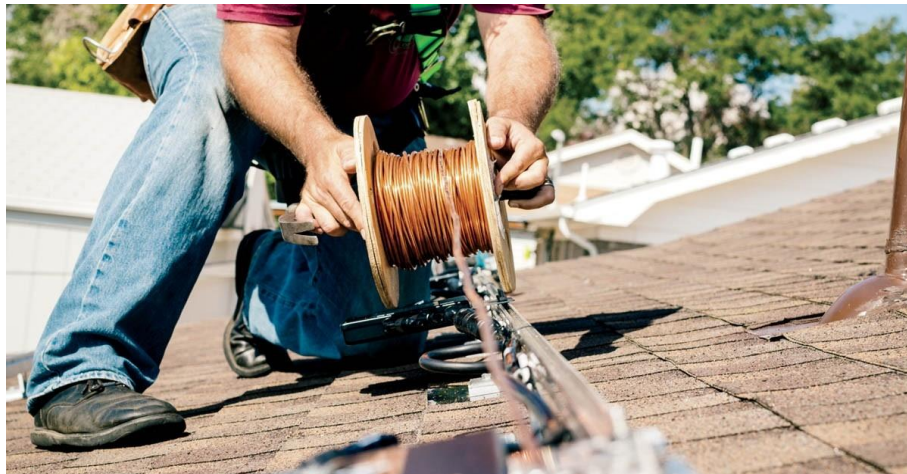
Gambar 8.1 Pembengkokkan saluran dan penarikan kabel
