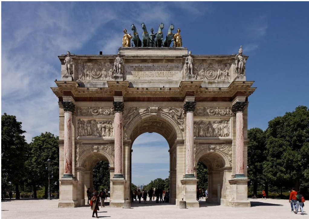
Gambar 1.7 ini adalah bangunan Arc de Triomphe du Carrousel yang terletak di Place du Carrousel, Paris, Prancis. Bangunan ini adalah contoh arsitektur Neoklasik dalam tatanan Korintus. Dibangun antara tahun 1806 dan 1808 untuk memperingati kemenangan militer Napoleon dalam Perang Koalisi Ketiga dan Keempat. Ciri khas bangunannya adalah menggunakan kolom-kolom layaknya bangunan romawi yang terdiri dari garis dengan tampilan yang rapi.
