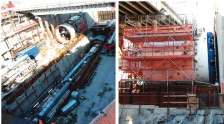
**Gambar 6.7 Mesin Pelindung Lumpur Untuk Proyek Akses Sisi Timur, Queens, New York. (Kiri) Perakitan Dua Mesin Bor Terowongan (TBM) Dan Roda Gigi Penariknya Di Lubang Peluncuran. (Kanan) Tampilan Dekat Kepala Pemotong TBM. Sumber: Y. Hashash.**
