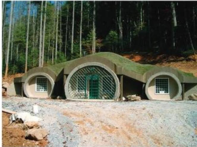
**Gambar 3.6 Rumah Yang Terlindung Dari Tanah Sebagian Berada Di Bawah Tanah, Sehingga Lebih Kuat Dan Hemat Energi.**
