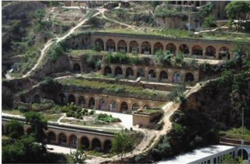
**Gambar 1.1 Contoh Yao Dong Bertingkat, Sejenis Hunian Gua Yang Diukir Pada Dinding Vertikal Atau Hampir Vertikal Dari Loess (Tanah Berlumpur), Di Provinsi Shaanxi Di Barat Laut Tiongkok.**
