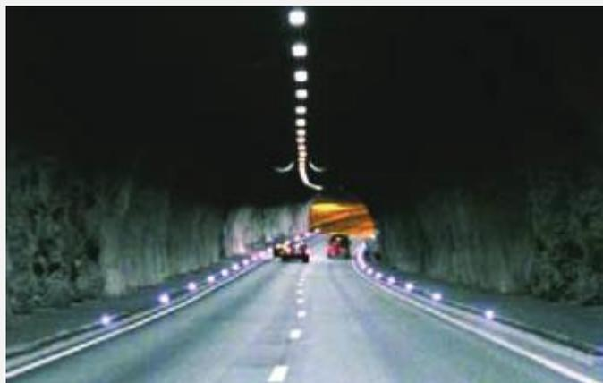
**Gambar 4.2 Beberapa Terowongan Di Eropa Menggunakan Dioda Pemancar Cahaya Yang Didistribusikan Secara Merata Untuk Membantu Pengendara Mengenal Tepi Jalan Dan Menentukan Jarak Aman Untuk Mengikuti Kendaraan.**
