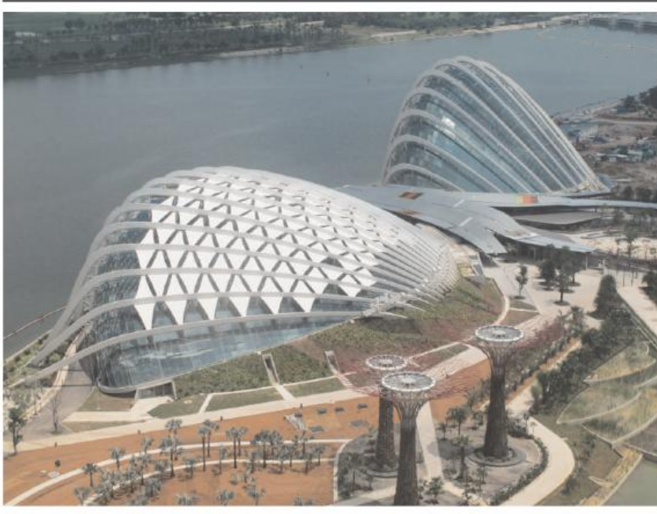
Gambar 15.2 Pemandangan Udara Dari Bioma Yang Menunjukkan Bayangan Yang Disebarkan Pada Bioma Sejuk Dan Kering; Pembuangan Udara Regenerasi Pengering Berasal Dari Pohon-Pohon Besar Di Latar Depan (& Atelier Ten)
