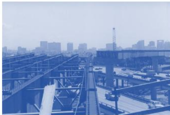
Gambar 4.1 Jembatan I-Girder Komposit Baja-Beton Yang Sedang Dibangun
