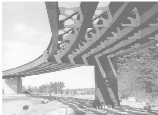
Gambar 6.1 Jembatan gelagar I lengkung sedang dibangun—20th Street HOV, Denver, CO.
