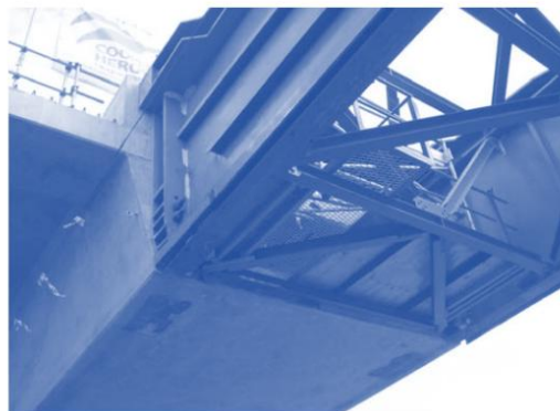
Gambar 3.26 Sambungan Hidung Peluncur Dan Segmen.
