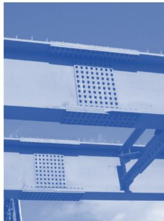
Gambar 4.10 Sambungan baut lapangan.
