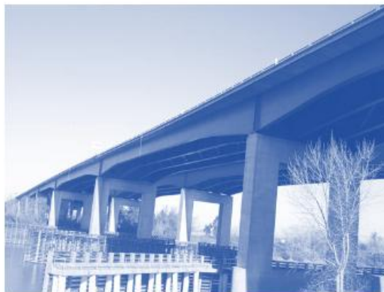
Gambar 4.7 Jembatan Girder Baja Kontinu
