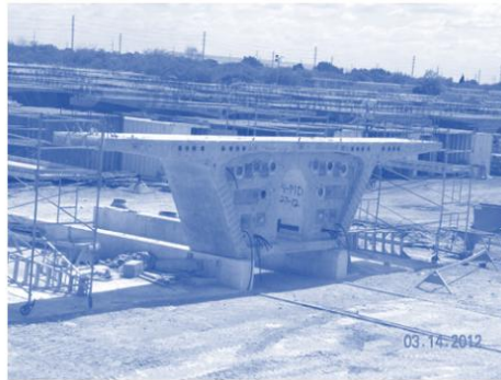
Gambar 3.17 Lokasi Penyimpanan Segmen.
