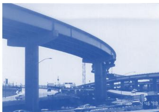
Gambar 4.2 Jembatan I-Girder Komposit Baja-Beton
