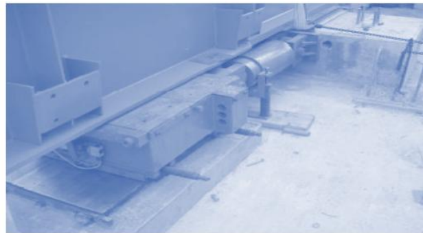
Gambar 3.29 Alat Pendorong Jembatan.
