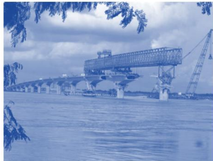
Gambar 3.19 Pemasangan Segmen Dengan Gantry Peluncur Di Atas Kepala.
