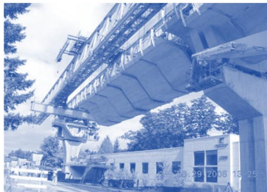
Gambar 3.24 Ereksi Segmen Bentang Demi Bentang Menggunakan Gantry Overhead.
