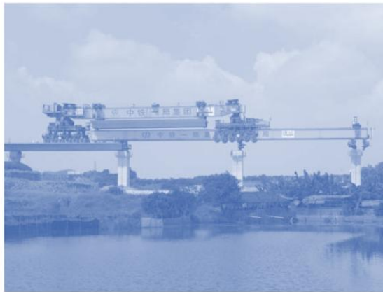
Gambar 3.30 Pemasangan Gelagar Bentang Penuh.
