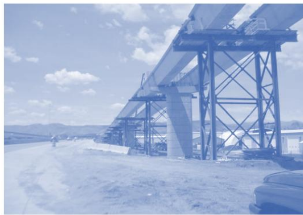
Gambar 3.32 U-Girder Pracetak Yang Ditopang Oleh Rangka Sementara.
