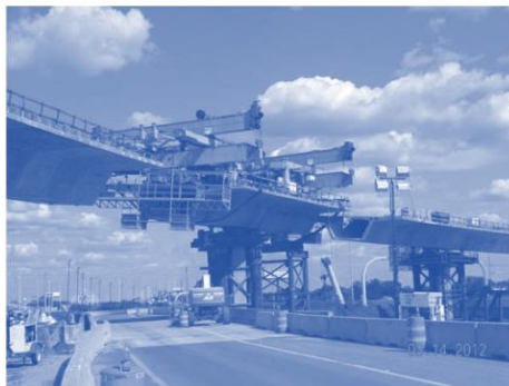
Gambar 3.20 Ereksi Segmen Dengan Pengangkat Segmen.
