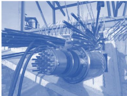
Gambar 2.2 Dongkrak prategang hidrolik pada umumnya. (Courtesy of California Department of Transportation.)
