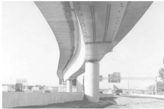
Gambar 6.5 Jembatan gelagar kotak tunggal dengan tutup bengkok integral—Ramp Y, I-95 Davies Blvd, Broward County, FL.
