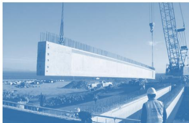
Gambar 1.7 Balok I bentang tunggal diturunkan ke abutmen di lokasi jembatan.
