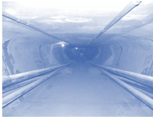
Gambar 3.22 Tendon Eksternal Di Dalam Girder Kotak.
