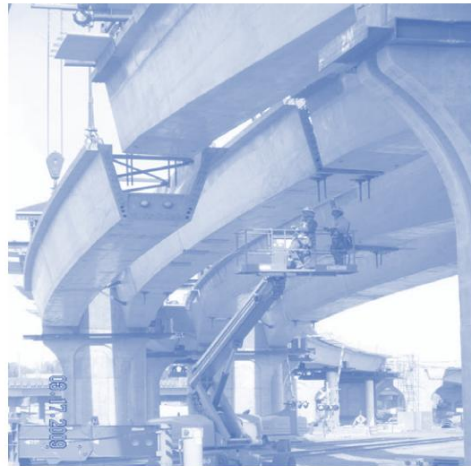
Gambar 3.31 Jembatan U-Girder Pracetak Yang Disambung Selama Pemasangan.
