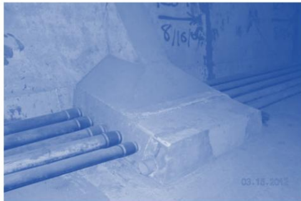
Gambar 3.6 Tendon eksternal pada deviator.
