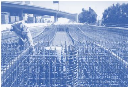
Gambar 2.1 Jembatan girder kotak pasca-tegang yang sedang dibangun.
