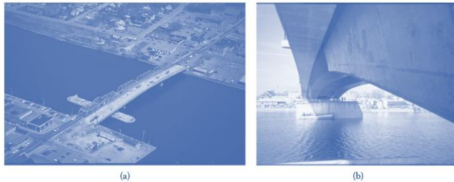
Gambar 5.25 Trenton, Ontario 1993. (a) Pemandangan jembatan dari udara. (b) Tampak bawah jembatan.
