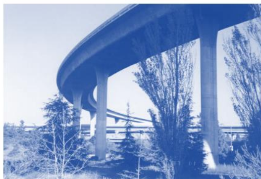
Gambar 2.6 Jembatan girder kotak prategang (Persimpangan I-280/110, California).
