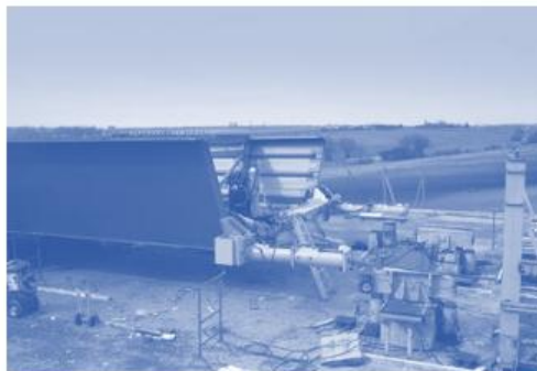
Gambar 5.23 Sistem hidraulik langkah pendek untuk bangunan atas ringan di Jembatan Schrotetal (1995–1997).
