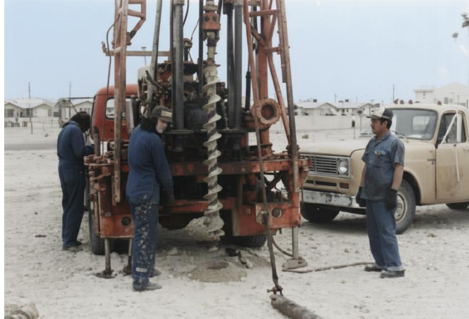
Gambar 10.3 Pengeboran dengan auger continuous-flight (Courtesy of Danny R. Anderson, Danny R. Anderson Consultants, El Paso, Texas)
