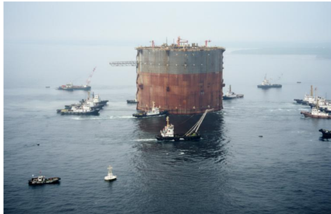
Gambar 3.19 Pemosisian Caisson Kotak Baja Jembatan Selat Akashi, Jepang
