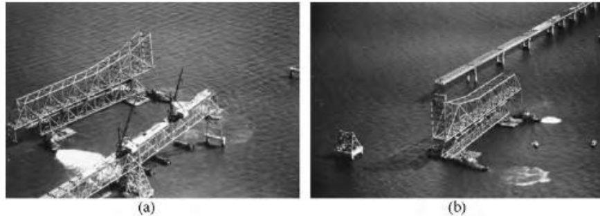
Gambar 1.30 Pemasangan Bentang Rangka Apung, Jembatan Teluk Chesapeake Pertama, Maryland, 197. Bentang Rangka Dek Sepanjang 300 Kaki (91 M) Yang Telah Dipasang Membentuk Dok Pemasangan, Menyediakan Platform Kerja Untuk Dua Alat Bantu Pemasangan Derek. Bentang Jembatan Rangka Permanen Berfungsi Sebagai Perancah Penyangga Yang Ditopang Oleh Tongkang Dan Ditunjukkan Membawa Lengan Jangkar Sepanjang 470 Kaki (143 M) Dari Rangka Kantilever. Bentang Ini Diapungkan Ke Posisi Permanennya, Kemudian Diturunkan Ke Dermaga Dengan Cara Memberi Pemberat Pada Tongkang. (A) Pelampung Meninggalkan Dok Pemasangan, Dan (B) Pelampung Tiba Di Posisi Permanen.
