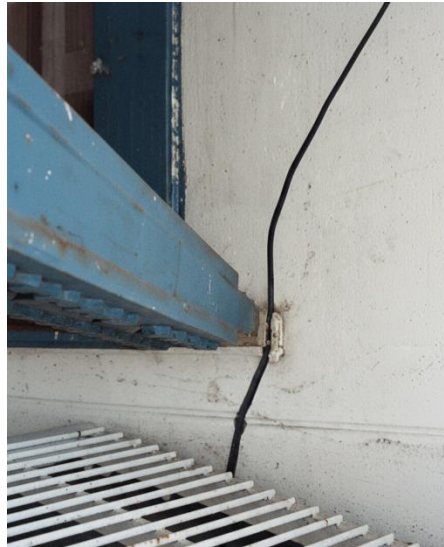
Gambar 9.2 Kegagalan Las Balok Melintang Jembatan Dan Ryan, Chicago
