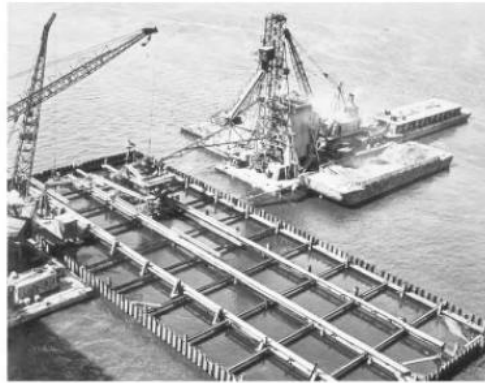
Gambar 3.9 Bendungan Sementara Tiang Pancang Lembaran Baja Besar Untuk Jembatan Memorial Delaware Kedua, Menunjukkan Rangka Penguat.
