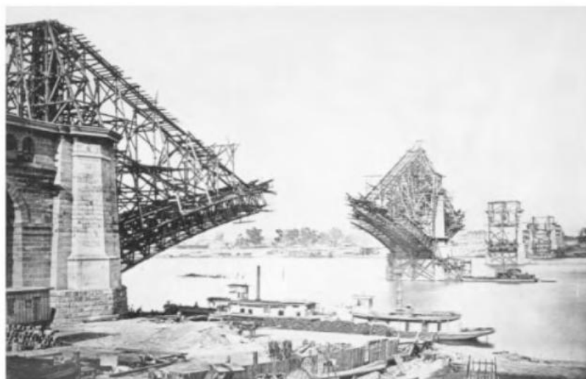
Gambar 1.15 Jembatan Eads Melintasi Sungai Mississippi, St. Louis, Mo., 1873. Jembatan Lengkung Logam Penting Pertama Di AS, Ditopang Oleh Empat Bidang Lengkung Rangka Tanpa Engsel Yang Memiliki Rangka Tubular Baja Krom. Bentangnya Berukuran 502-520-502 Kaki (153-158-153 M). Selama Pemasangan, Rangka Lengkung Diikat Kembali Dengan Kabel
