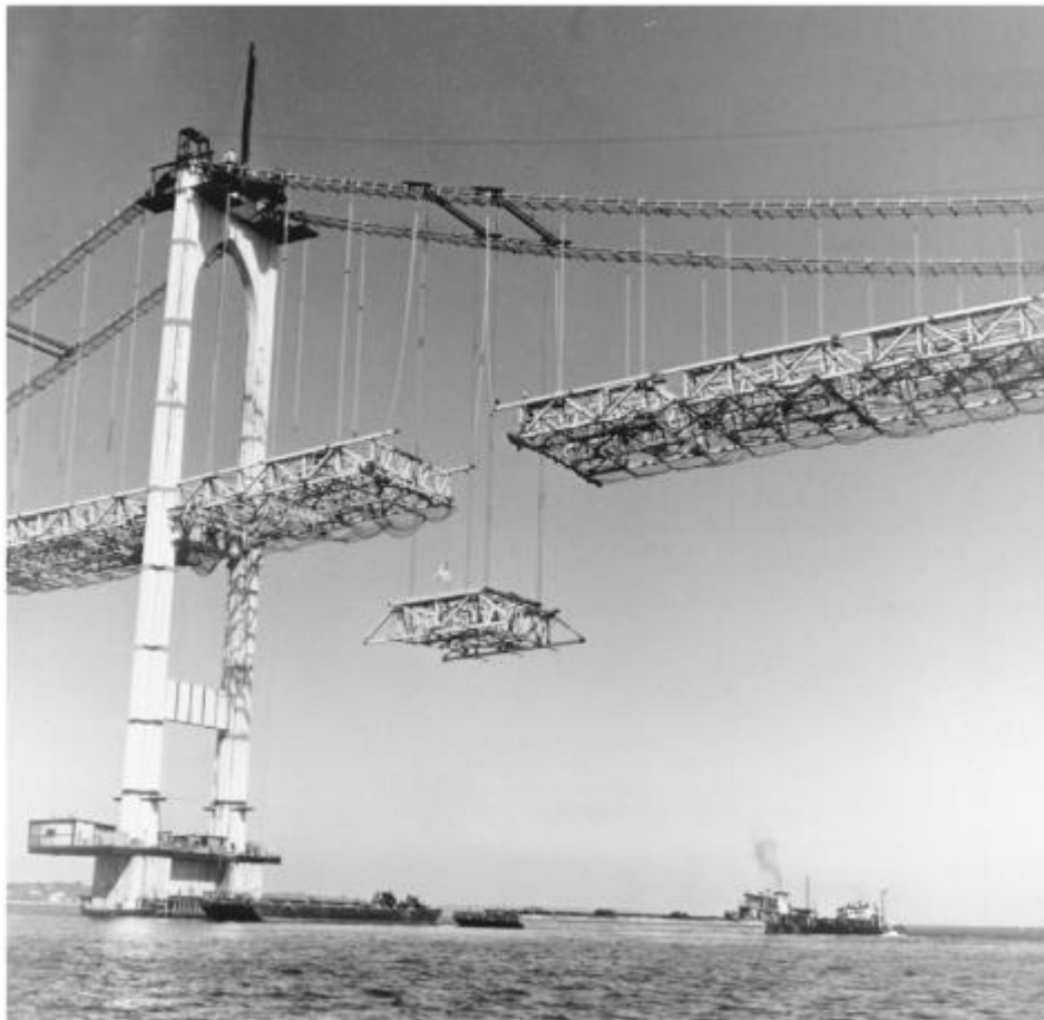
Gambar 1.40 Pemasangan struktur baja dek gantung, bentang gantung Jembatan Newport, Teluk Narragansett, R.I., 1968. Bagian dek bentang utama penutup sedang diangkat ke posisinya oleh dua penggerak kabel, masing-masing terdiri dari sepasang balok gulungan berflensa lebar 36 inci (0,91 m) yang bergerak di atas kabel pada roda kayu. Bagian penutup memiliki panjang 40 1/2 kaki (12 m) pada tingkat korda atas, lebar 66 kaki (20 m) dan
