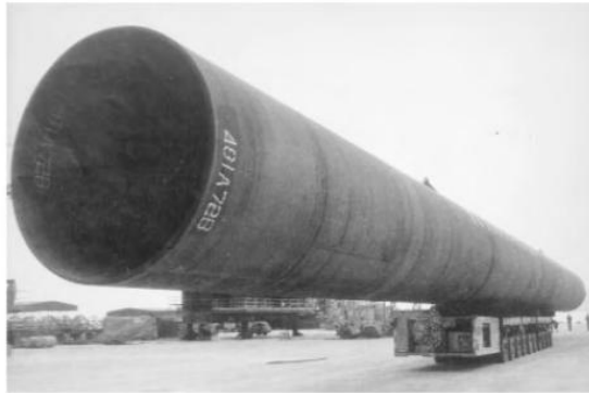
Gambar 3.1 Tiang Pancang Tubular Baja Berdiameter Besar, Jembatan Sungai Jamuna, Bangladesh
