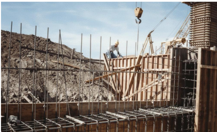
Gambar 4.3 Konstruksi dinding sayap dan abutmen.
