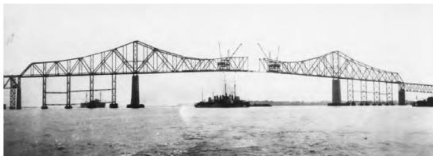
Gambar 1.21 Jembatan Kantilever Cooper River Pertama, Charleston, S.C., 1929. Alat Bantu Pemasangan (Errection Traveler) Membangun Bentang Samping Sepanjang 450 Kaki (137 M) Di Atas Perancah, Kemudian Melanjutkan Pemasangan Bentang Utama Sepanjang 1050 Kaki (320 M) (Termasuk Bentang Gantung Sepanjang 437,5 Kaki [133 M]) Dengan Cara Kantilever Hingga Ke Tengah Bentang.
