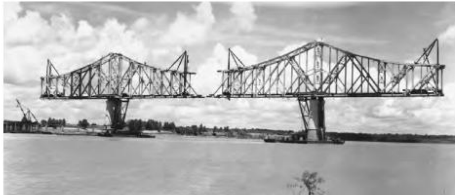
Gambar 1.23 Pemasangan Kantilever Seimbang, Jembatan Kantilever Kereta Api/Jalan Raya Governor O.K. Allen, Baton Rouge, La., 1939. Penggunaan Pertama Prosedur Pemasangan Kantilever Seimbang Panjang Di AS. Pada Setiap Pilar, 650 Kaki (198 M) Struktur Baja, Sekitar 4000 Ton, Diseimbangkan Pada Dasar 40 Kaki (12 M) Yang Dibentuk Oleh Kerangka Kerja Miring. Beban Tekan Di Bagian Atas Kerangka Kerja Diukur Secara Berkala Dan Disesuaikan Dengan Memposisikan Kereta Penyeimbang Yang Berjalan Pada Tingkat Tali Bawah. Bentang Utama Jembatan Ini Berukuran 848-650-848 Kaki (258-198-258 M); Bentang 650 Kaki Ditampilkan.
