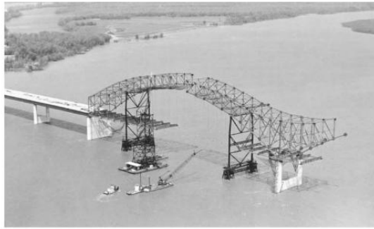
Gambar 1.43 Pemasangan bentang lengkung barat Jembatan Hernando de Soto lengkung kembar, Memphis, Tenn., 1972. Dua bentang lengkung terikat rangka kontinu sepanjang 900 kaki (274 m) didirikan oleh kapal derek menara tinggi yang menggabungkan sepasang tongkang. Struktur baja lengkung barat (ditunjukkan) dikantileverkan ke tengah bentang di atas dua penyangga perancah yang ditopang tiang pancang. Struktur baja lengkung timur yang menjorok (di sebelah kanan) kemudian dikantileverkan ke tengah bentang (tanpa perancah) dan ditutup dengan setengah lengkung lainnya yang ditopang perancah. (Sumber: Bethlehem Steel Corporation.)
