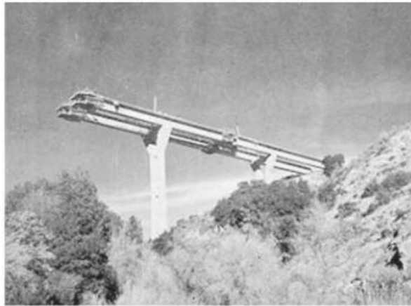
Gambar 2.2 Jembatan Pine Valley Creek — Konstruksi Di Pilar 4.
