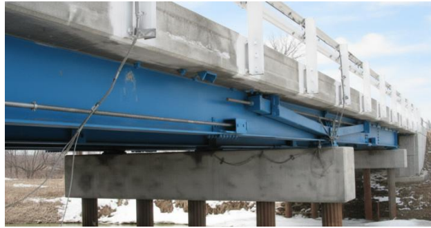
Gambar 6.24 Sistem rangka bertumpuk. (a) Rangka bertumpuk; (b) foto rangka bertumpuk.
