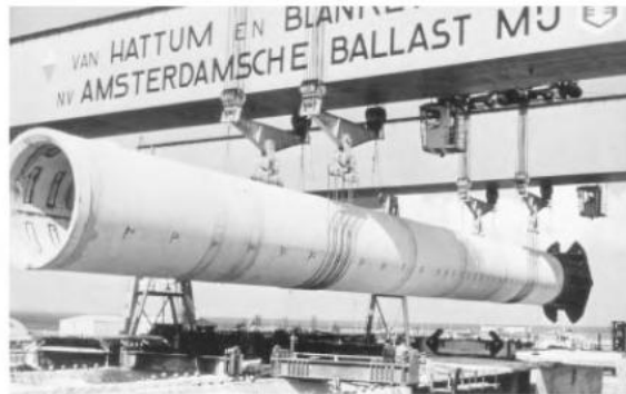
Gambar 3.7 Tiang Pancang Silinder Beton Prategang Untuk Jembatan Oosterschelde, Belanda.
