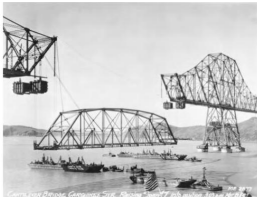
Gambar 1.20 Pengangkatan Bentang Gantung, Jembatan Selat Carquinez, California, 1927. Bentang Gantung Sepanjang 433 Kaki (132 M), Dengan Berat 650 Ton, Diangkat Ke Posisinya Dalam 35 Menit, Didorong Oleh Empat Kotak Penyeimbang Dengan Total Berat 740 Ton.
