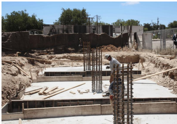
Gambar 4.1 Cetakan pondasi.
