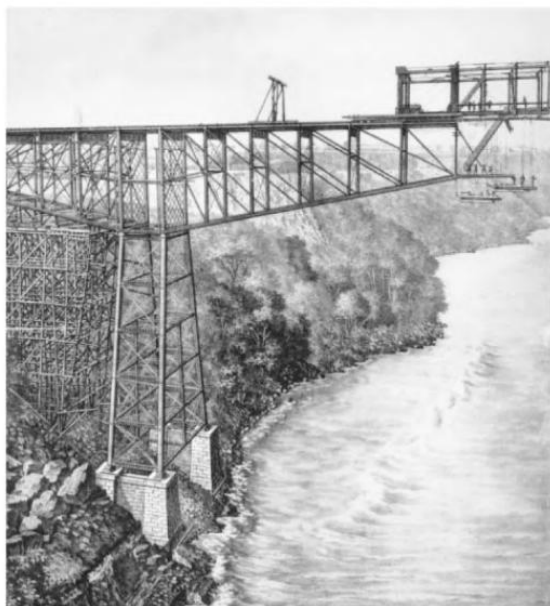
Gambar 1.17 Jembatan Rangka Kantilever Kereta Api Sungai Niagara, Dekat Air Terjun Niagara, New York, 1883. Alat Bantu Pemasangan Kayu Besar Digunakan Untuk Membangun Bentang Samping Di Atas Perancah, Kemudian Setengah Dari Bentang Utama Dikantileverkan
