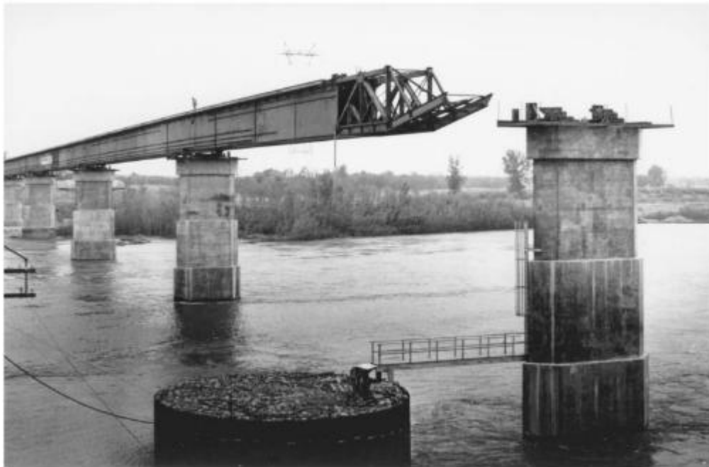
Gambar 1.41a Ujung depan rangkaian balok utara bergerak melintasi bentang 4 sepanjang 250 kaki (76 m), mendekati pilar 5. Bentang utama sepanjang 330 kaki (101 m) berada di sebelah kanan pilar 5.
