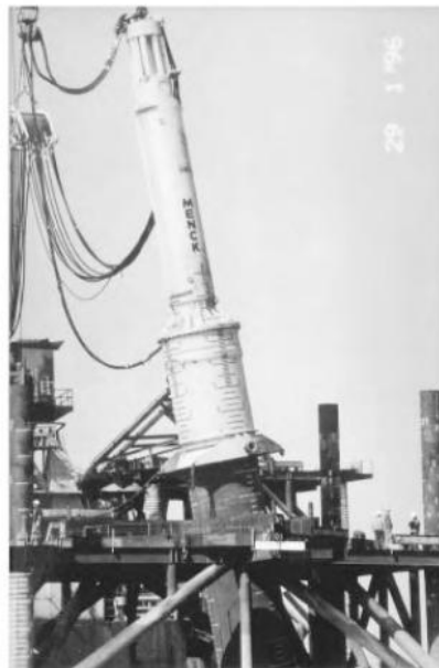
Gambar 3.2 Pemasangan Tiang Pancang Tubular Baja Berdiameter Besar.
