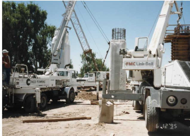
Gambar 4.2 Penahan Sangkar Kolom dengan Derek
