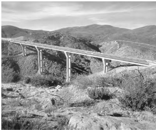
Gambar 2.5 Jembatan Pine Valley Creek — Penyelesaian Konstruksi.
