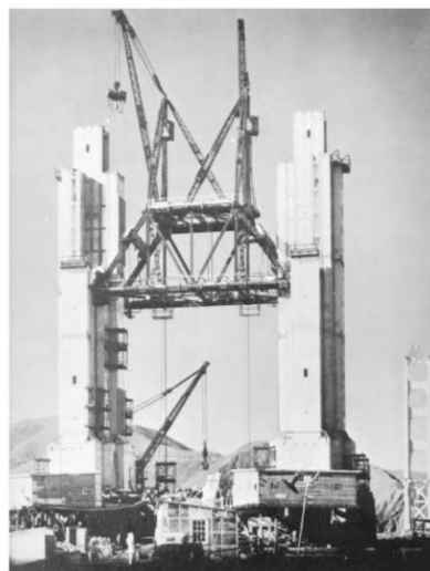
Gambar 1.22 Pemasangan Menara Selatan Jembatan Golden Gate, San Francisco, 1935. Alat Bantu Pemasangan (Creeper Traveler) Dengan Dua Lengan Sepanjang 90 Kaki (27 M) Memasang Satu Tingkat Sel Menara Untuk Setiap Kaki, Kemudian Dilompatkan Ke Puncak
