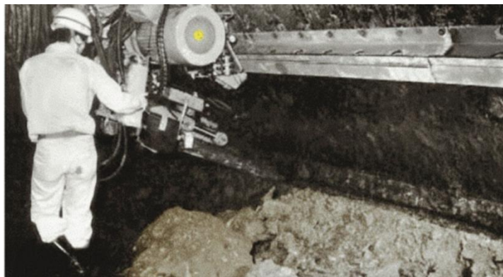
Gambar 3.18 Penggalian di Tepi Pemotong Caisson Pneumatik
