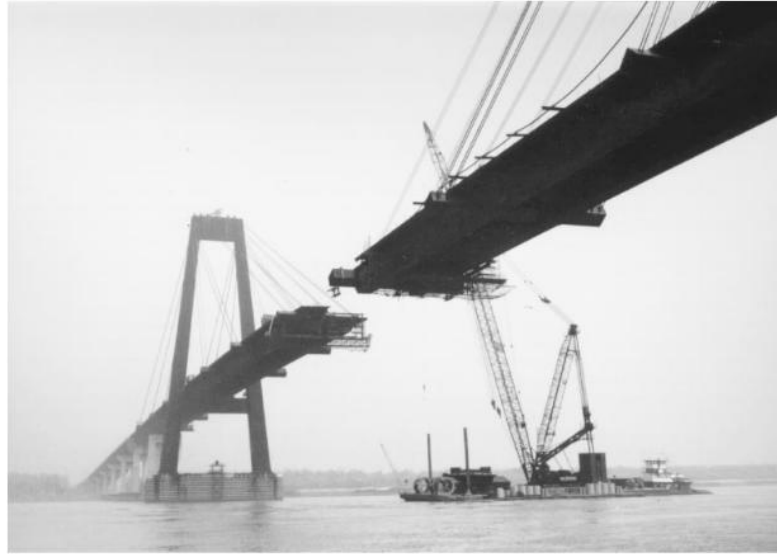
Gambar 1.9 Jembatan Dek Baja Ortotropik Kabel-Stayed Di Atas Sungai Mississippi Di Luling, La., 1982; Tampilan Menghadap Timur Laut. Bentang Utama Adalah 1222 Kaki (372 M); Menara Rangka A Setinggi 350 Kaki (107 M). Sebuah Derek Pengangkat Yang Dipasang Di Tongkang Mendirikan Struktur Baja Utama, Menggunakan Lengan Sepanjang 340 Kaki (104 M) Dengan Jib Sepanjang 120 Kaki (37 M) Untuk Mendirikan Komponen Menara Yang Beratnya Hingga 183 Ton, Dan Menggunakan Lengan Yang Lebih Pendek Untuk Komponen Dek. Kabel Penahan Di Ujung Balok Melintang Yang Menjorok Bersifat Permanen; Yang Lainnya Adalah Penahan Pemasangan Sementara. Bagian Balok 16-Barat Dari Bagian Utara Jembatan, Yang Didirikan Beberapa Hari Sebelumnya, Menjorok Di Sebelah Kiri; Bagian Balok Pendamping 16-Timur Berada Di Tongkang Siap Untuk Dipasang (Lihat Gambar 1.10).
