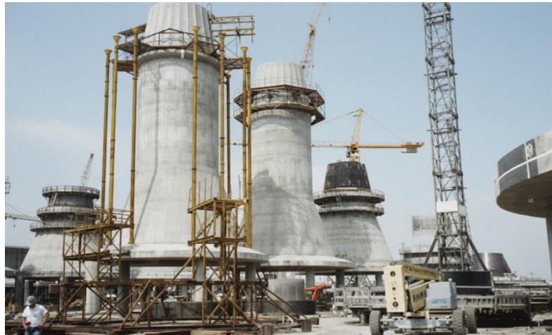
Gambar 3.25 Prafabrikasi dasar pilar, Jembatan Pulau Prince Edward, Kanada.
