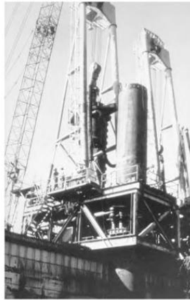
Gambar 3.3 Tiang Pancang Tubular Baja Dipasang Dari Tongkang Jack-Up. Lubang Akan Dibor Ke Dalam Batuan Dan Seluruh Tiang Diisi Dengan Beton Tremie.
