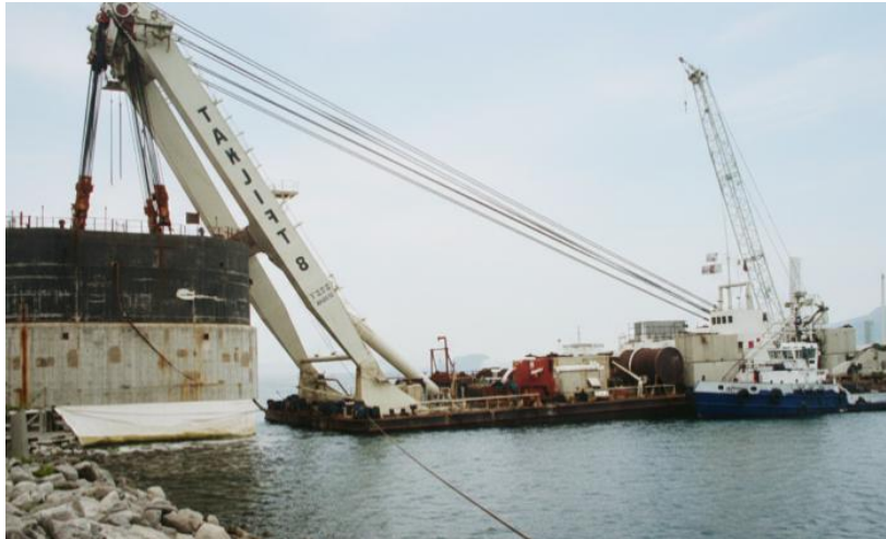
Gambar 3.29 Pengangkatan dan Pengangkutan Kotak Caisson dari Dermaga
