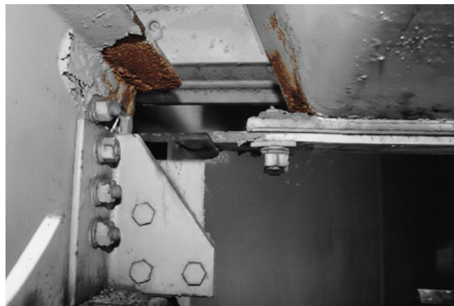
Gambar 9.5 Perbaikan Retakan Balok Lantai Jembatan Throgg's Neck, NY
