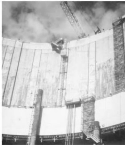
Gambar 3.11 Bendungan Sementara Dinding Cincin Beton Yang Dibangun Dengan Metode Parit Lumpur.
