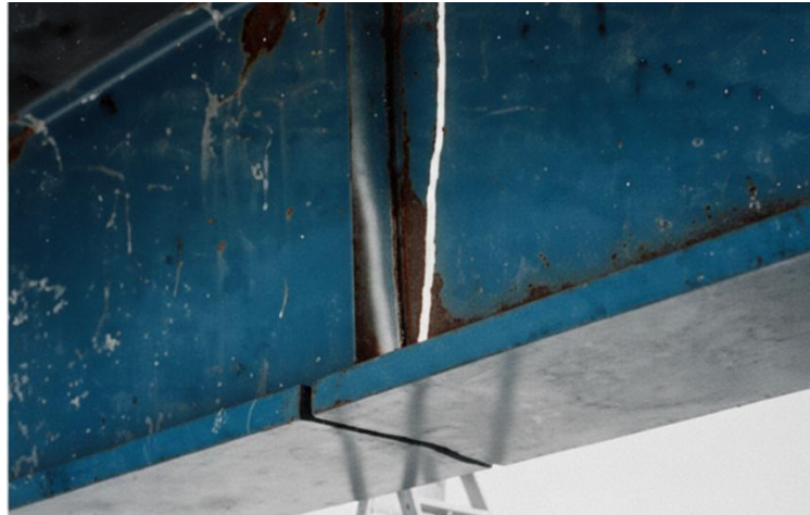
Gambar 9.3 Tampilan balok yang retak dari Jembatan I-79 di Pulau Neville di Pittsburgh sebagai contoh jembatan yang cukup redundan untuk menghindari keruntuhan meskipun terjadi patahan pada flensa tarik dan web.
