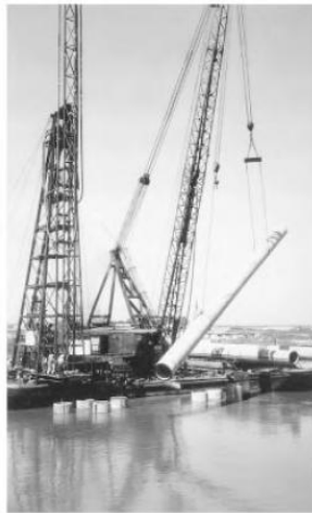
Gambar 3.6 Tiang Pancang Beton Prategang Berdiameter Besar, Jembatan Sungai Napa, California.
