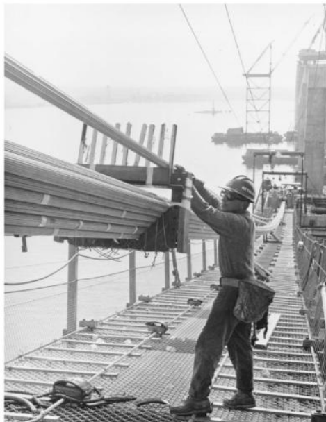
Gambar 1.37b Pembentuk Kabel Mempertahankan Keselarasan Untaian Dalam Kabel Sebelum Pemadatan Kabel. Setiap Kabel Jadi Berdiameter Sekitar 15-1/4 Inchi (387 Mm).
