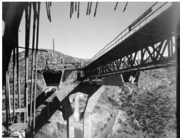
Gambar 2.4 Jembatan Pine Valley Creek — Konstruksi Balok
