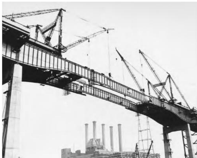
Gambar 1.29 Memasang Bagian Balok Penutup Jembatan Sungai Passaic, New Jersey Turnpike, 197. Alat Pengangkat Ganda Yang Sangat Besar, Masing-Masing Seberat 270 Ton, Memasang Balok Pelat Penutup Bentang Utama Sepanjang 375 Kaki (114 M). Balok Penutup Memiliki Kedalaman 14 Kaki (4,3 M) Dan Panjang 115 Kaki (35 M) Serta Berat Masing-Masing 146 Ton. Pemasangan Dari Samping Diperlukan (Seperti Yang Ditunjukkan) Karena Material Sambungan Yang Menonjol Panjang. Gerakan Memanjang Disediakan Di Salah Satu Pilar, Di
