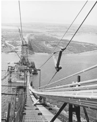
Gambar 1.37a Kereta Gantung Menarik PWS Dari Jangkar Barat Ke Bentang Samping, Kemudian Melintasi Bentang Lainnya Ke Jangkar Timur. Untaian Berdiameter Sekitar 1 3/4 Inchi (44 Mm).
