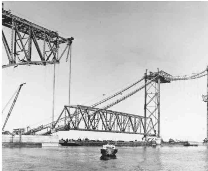
Gambar 1.32 Pemasangan Bentang Rangka Dengan Pengangkatan, Jembatan Teluk Chesapeake Pertama, Maryland, 198. Bentang Rangka Sepanjang 360 Kaki (110 M) Diangkat Ke Posisi Yang Diinginkan Menggunakan Tongkang Dan Dipindahkan Menggunakan Empat Set Kerekan Pengangkat. Dek Jembatan Gantung Sedang Dalam Pembangunan Di Sebelah Kanan.
