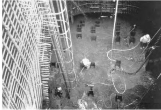
Gambar 3.13 Bendungan Sementara Yang Telah Dipompa Keluar Menunjukkan Segel Beton Tremie Dan Tiang Pancang H Baja Yang Telah Dipasang Sebelumnya.
