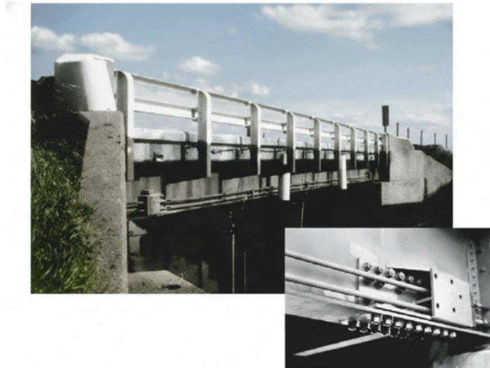
Gambar 6.23 Jembatan bentang tunggal yang diperkuat dengan prategang.
