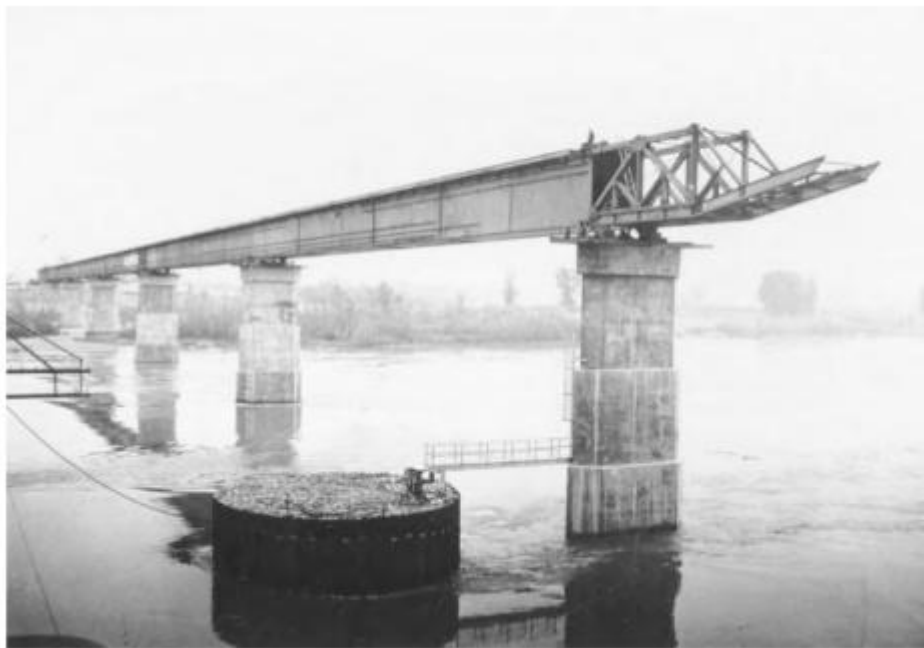
Gambar 1.41c Ujung depan rangkaian balok utara sekarang ditopang di dermaga 5.
