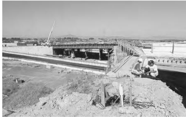
Gambar 2.6 Perancah Pada Konstruksi I-80 HOV, Richmond, CA.
