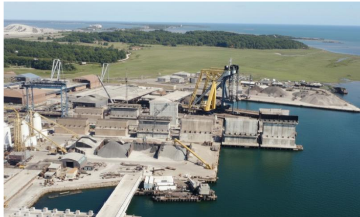
Gambar 3.21 Pra-fabrikasi pilar caisson kotak untuk Jembatan Great Belt Barat, Denmark.
