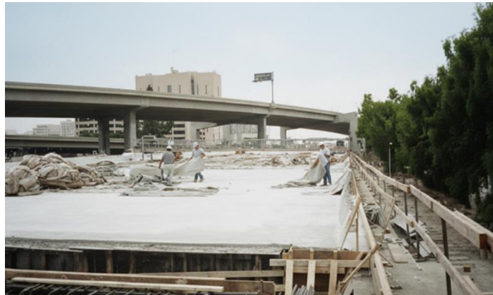
Gambar 4.9 Dek jembatan sedang dirawat dengan karpet basah.
