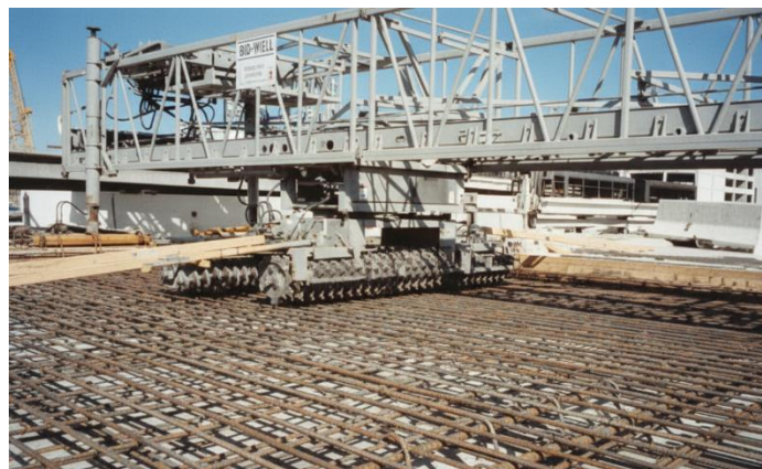
Gambar 4.5 Tulangan dek jembatan dengan mesin finishing bidwell.
