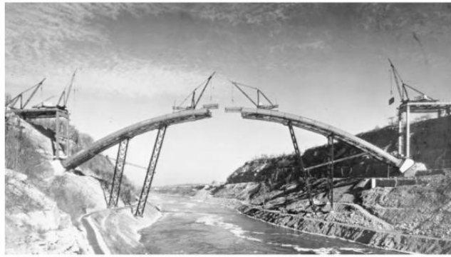
Gambar 1.4 Jembatan Lengkung Lewiston-Queenston, Dekat Niagara Falls, New York, 1918. Bentang Lengkung Tetap Terpanjang Di AS Dengan Panjang 1000 Kaki (305 M); Tingginya 159 Kaki (48 M). Penampang Rusuk Lengkung Kotak Biasanya Berukuran Sekitar 3 \times 13 - \frac{1}{2} Kaki ( 0,9 \times 4,1 M) Dalam Penampang Melintang Dan Sekitar 44 - \frac{1}{2} Kaki (13,6 M). Pekerjaan Diperkirakan Menggunakan Penahan Pemasangan (Sama Seperti Yang Ditunjukkan Pada Gambar 1.3), Tetapi Studi Selanjutnya Menunjukkan Bahwa Penyangga Miring Yang Panjang Lebih Ekonomis (Meskipun Terlihat Kurang Aman). Banyak Struktur Baja Permanen Digunakan Pada Perancah Penyangga. Derek Di Jalan Pendekatan Memuat Struktur Baja Ke Gerbong Material Yang Bergerak Naik Di Sepanjang Rusuk Lengkung. Gerbong Pengangkut Berkapasitas 115 Ton Terlihat Sedang Memasang Bagian Rusuk Lengkung Penuh Terakhir, Sehingga Hanya Menyisakan Bagian Mahkota Penutup Yang Pendek Untuk Dipasang. Kanada Berada Di Sebelah Kiri, AS Di Sebelah Kanan.
