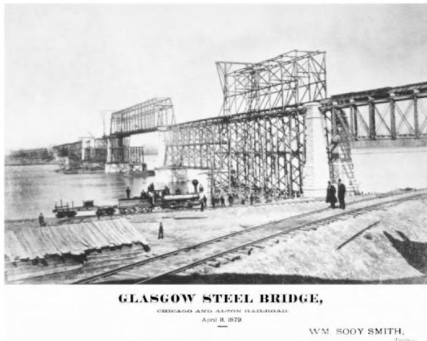
Gambar 1.16 Jembatan Rangka Kereta Api Glasgow (Missouri), 1879. Pemasangan Di Atas Perancah Pendukung Penuh Adalah Hal Biasa Pada Abad Ke-19. Jembatan Baja Pertama Di Dunia, Dengan Lima Bentang Rangka Sederhana Sepanjang 315 Kaki (96 M), Melintasi Sungai Missouri.
