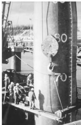
Gambar 3.4 Tiang Pancang Baja Tubular Berdiameter Besar Sedang Diposisikan.
