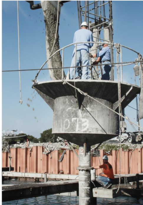
Gambar 3.14 Pengecoran Beton Bawah Air, Jembatan Verrazano-Narrows
