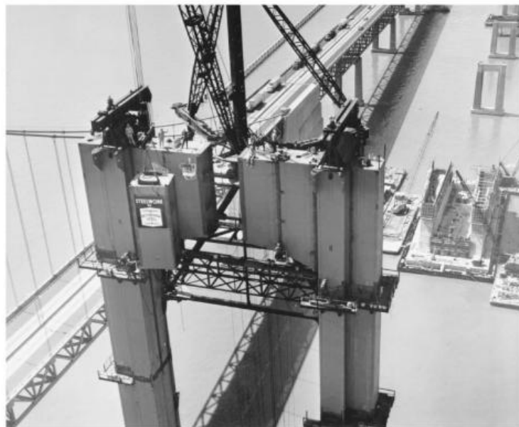
Gambar 1.35 Pemasangan Menara, Jembatan Memorial Delaware Kedua, Wilmington, Del., 1922. Alat Bantu Pemasangan Menara Telah Mencapai Posisi Pemasangan Tertinggi Dan Mengayunkan Bagian Penyangga Atas Penutup Seberat 23 Ton Ke Tempatnya. Kaki Menara Diregangkan Sekitar 2 Inchi (50 Mm) Untuk Memberikan Ruang Masuk. Balok Lompat Alat Bantu Pemasangan Berada Di Posisi Kerja Tertinggi, Di Atas Dudukan Kabel. Struktur Baja Menara Tingginya Sekitar 418 Kaki (127 M). Dermaga Jangkar Kabel Sedang Dibangun Di Sebelah Kanan. Jembatan Memorial Delaware Pertama (1951) Berada Di Sebelah Kiri. Bentang Utama Kedua Jembatan Adalah 2150 Kaki (655 M).
