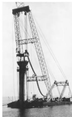
Gambar 3.8 Pemasangan Tiang Silinder Beton Dengan Penggalan Internal, Penyemprotan, Dan Gaya Tarik Ke Bawah Dari Tongkang.
