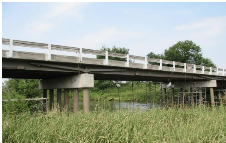
Gambar 6.26 Foto jembatan kontinu tiga bentang yang diperkuat dengan prategang dan rangka yang ditumpangkan.
