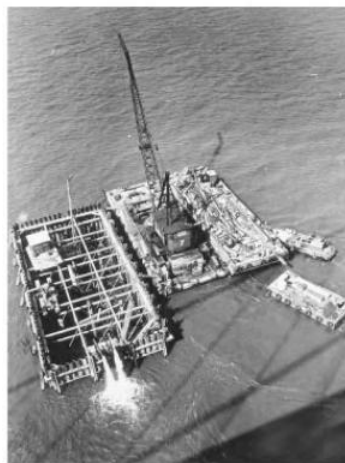
Gambar 3.12 Pengeringan Bendungan Sementara Untuk Pilar Menara Utama, Jembatan Memorial Delaware Kedua.
