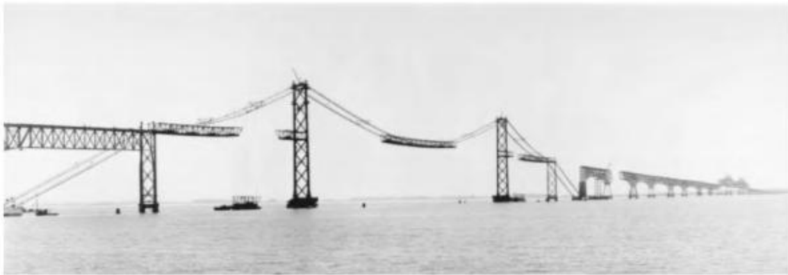
Gambar 1.6 Bentang Suspensi Jembatan Teluk Chesapeake Pertama, Maryland, 198. Struktur Baja Dek Sedang Dipasang Dan Telah Selesai Sekitar 50%. Bagian Dek Rangka Tembus Empat Panel Yang Khas, Dengan Berat Sekitar 100 Ton, Sedang Diangkat Di Bentang Sisi Barat, Dan Juga Di Bentang Sisi Timur Pada Jarak Tertentu. Bentang Utama Adalah 1600 Kaki (488 M) Dan Bentang Samping Adalah 661 Kaki (201 M); Menara Setinggi 324 Kaki (99 M). Kabel Berdiameter 14 Inchi (356 Mm) Dan Terdiri Dari 61 Untaian Jembatan Heliks Masing-Masing (Lihat Gambar 1.8).
