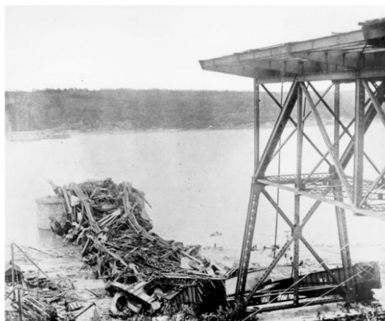
Gambar 1.12 Puing-Puing Bentang Jangkar Selatan Jembatan Kantilever Kereta Api Quebec Pertama, 1907. Pemandangan Menghadap Utara Dari Pantai Selatan Beberapa Hari Setelah Runtuhnya Jembatan Pada 29 Agustus 1907, Bencana Terburuk Dalam Sejarah Konstruksi
