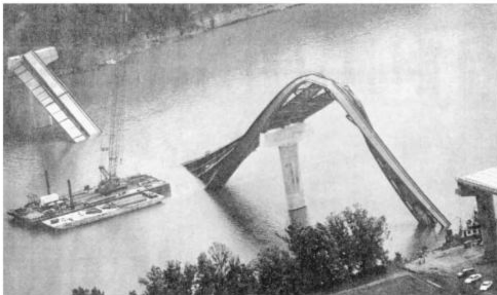
Gambar 1.1 Kegagalan Jembatan Girder Baja Selama Pemasangan, 1995. Kegagalan Jembatan Baja Seperti Ini Menimbulkan Kecurigaan Bahwa Aspek Rekayasa Konstruksi Tidak Diperhatikan Dengan Benar.
