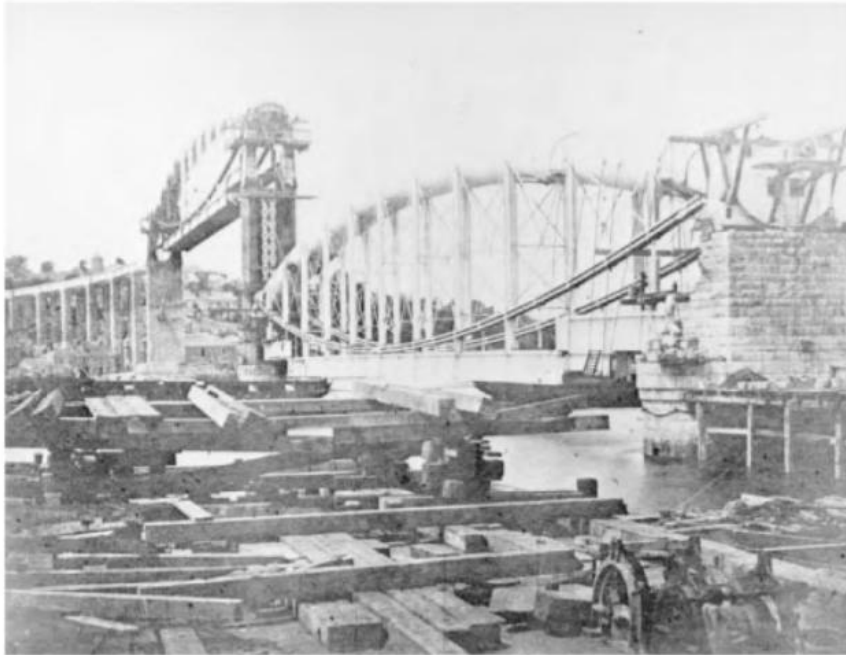
Gambar 1.14 Jembatan Royal Albert Melintasi Sungai Tamar, Saltash, Inggris, 1813. Dua Bentang Utama Sepanjang 455 Kaki (139 M), Masing-Masing Seberat 1060 Ton, Dibangun Di Darat, Diapungkan Dengan Sepasang Tongkang, Dan Diangkat Sekitar 100 Kaki (30 M) Ke Posisi Akhirnya Menggunakan Dongkrak Hidrolik. Konstruksi Pilar Dibangun Setelah Setiap Pengangkatan 3 Kaki (1 M).
