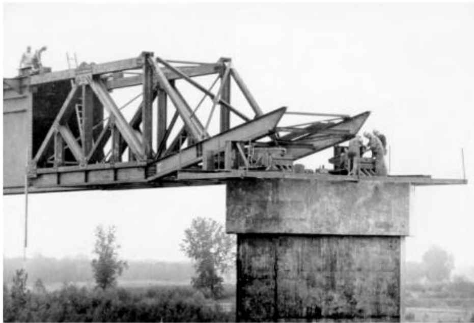
Gambar 1.41b Ujung depan peluncur naik ke unit jalur luncur dermaga 5, menghilangkan lendutan ujung depan rangkaian balok.
