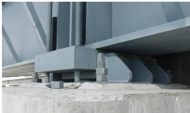
Gambar 4.8 Rakitan bantalan balok pelat baja.
