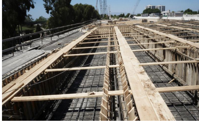
Gambar 4.4 Bekisting batang dan bagian bawah jembatan untuk balok kotak beton.
