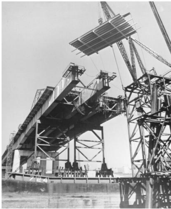
Gambar 1.36 Pemasangan panel dek pelat ortotropik, Jembatan Poplar Street, St. Louis, Mo., 1923. Jembatan balok kotak kontinu lima bentang, 2165 kaki (660 m), bentang utama 600 kaki (183 m). Rusuk kotak yang menonjol memiliki penampang 5\frac{1}{2} \times 17 kaki ( 1,7 \times 5,2 m), dan bagian dek berukuran 27 \times 50 kaki ( 8,2 \times 15,2 m). Bagian dek dilas di lapangan, sedangkan semua sambungan lainnya dibaut di lapangan. Balok kotak ditopang secara kantilever ke kerangka perancah menggunakan "penyangga posisi" di atas (struktur segitiga yang terlihat di atas dek di sebelah kiri) untuk penyangga sementara.
