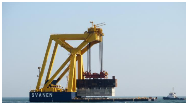
Gambar 3.31 Pemasangan Caisson Kotak Prefabrikasi Jembatan Great Belt Barat, Denmark
