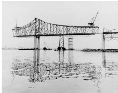
Gambar 1.44 Penutupan bentang sisi timur, jembatan rangka kantilever Commodore John Barry, Chester, Pa., 1973. Sebuah kapal derek menara tinggi (di latar belakang) memulai pemasangan rangka di kedua pilar utama, ditopang oleh perancah; kemudian memasang alat bantu pemasangan rangka atas untuk bentang utama dan samping. Alat bantu pemasangan bentang samping membawa pemasangan struktur baja hingga penutupan, seperti yang ditunjukkan, dan perancah kemudian dilepas. Alat bantu pemasangan bentang utama timur kemudian menopang struktur baja (tanpa perancah) ke tengah bentang, bersamaan dengan pemasangan kantilever oleh alat bantu pemasangan bentang utama setengah barat, dan rangka ditutup di tengah bentang. Commodore Barry memiliki bentang utama 1644 kaki (501 m), bentang kantilever terpanjang di AS, dan bentang samping 822 kaki (251 m). (Sumber: Bethlehem Steel Corporation.)
