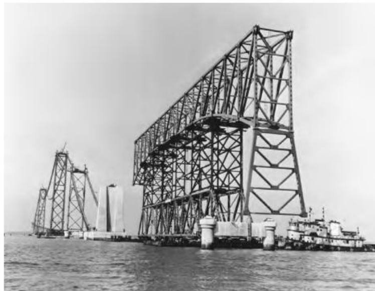
Gambar 1.31 Pemasangan Bentang Jembatan Rangka Dengan Cara Mengapung, Jembatan Teluk Chesapeake Pertama, Maryland, 198. Bentang Jembatan Rangka Sepanjang 480 Kaki (146 M), Dengan Berat 850 Ton, Ditopang Oleh Perancah Yang Terdiri Dari Bentang Jembatan Rangka Permanen Beserta Anggota Sementara, Sedang Diapungkan Untuk Diturunkan Ke Dermaga. Kabel Jembatan Gantung Sedang Dibangun Di Latar Belakang.
