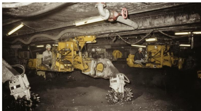
Gambar 3.17 Penggalan Caisson Pneumatik Jembatan Gantung Pelangi, Tokyo
