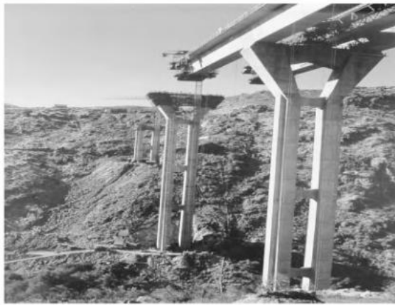
Gambar 2.3 Jembatan Pine Valley Creek — Konstruksi Pilar
