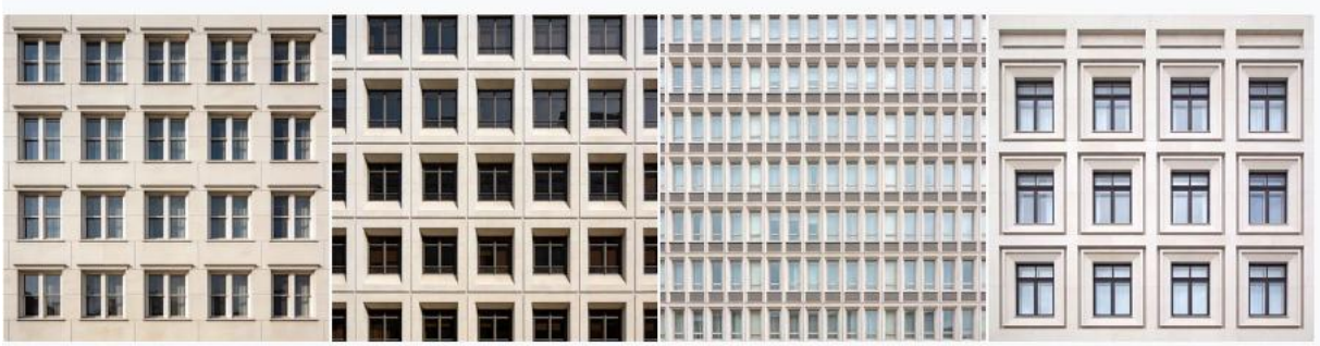
Gambar 3.19. Deretan jendela pada bangunan menciptakan ritme berulang yang stabil dan formal
