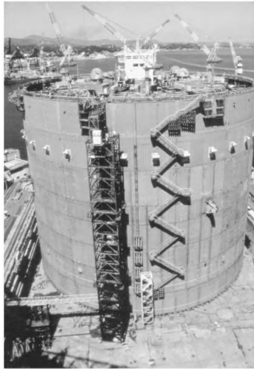
Gambar 4.35 Caisson Baja.
