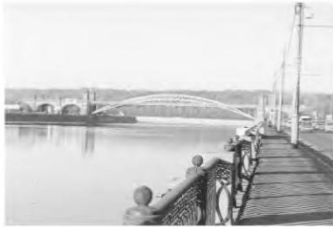
Gambar 5.4 Jembatan Kereta Api Lengkung Baja Di Atas Sungai Moskva.
