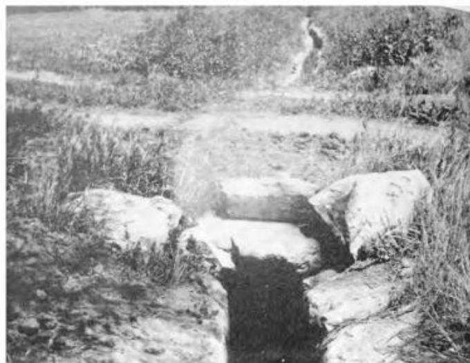
Gambar 6.1 Jembatan Akuaduk Di Misi La Purisima, Santa Barbara County, California, Adalah Contoh Jembatan Primitif, Yaitu Jembatan Lempengan Batu Bentang Pendek. Dibangun Pada Tahun 1813, Jembatan Ini Merupakan Jembatan Tertua Di California.
