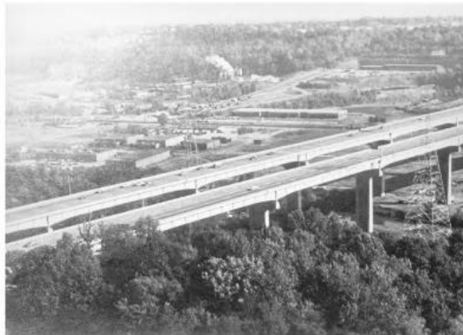
Gambar 6.44 Jembatan Lembah Sungai Cuyahoga Yang Dibangun Pada Tahun 1980 Untuk Otoritas Jalan Tol Ohio Memperoleh Penghargaan Aisc Pada Tahun Itu. Jembatan Ini Dirancang Oleh Howard Needles Tamman Bergendoff.
