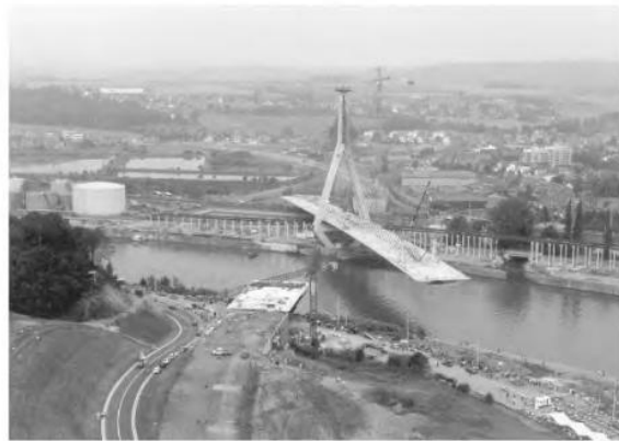
Gambar 3.17 Jembatan Ben Ahin Saat Berputar.
