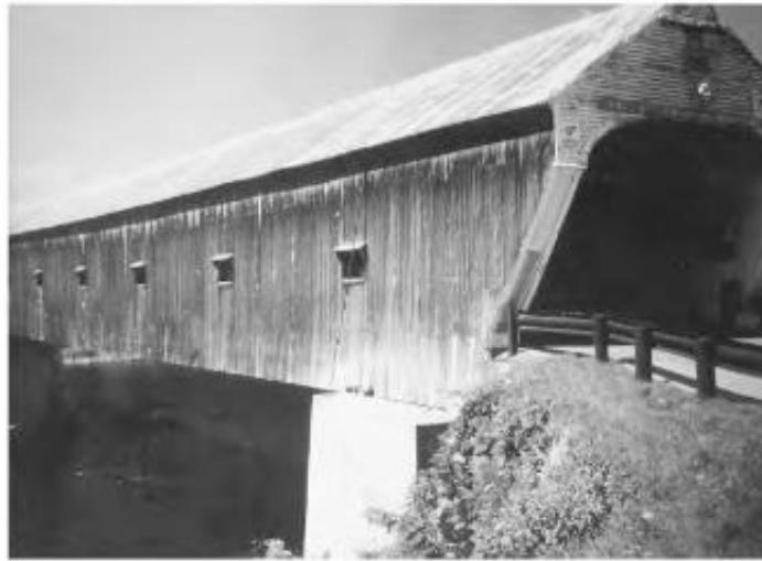
Gambar 6.5 Jembatan Beratap Cornish–Windsor Adalah Jembatan Rangka Kisi-Kisi Dua Bentang Yang Melintasi Sungai Connecticut Antara Cornish, New Hampshire Dan Windsor, Vermont. Dibangun Pada Tahun 1866, Jembatan Ini Merupakan Jembatan Beratap Terpanjang Di Amerika Serikat, Dengan Panjang 140,2 M. Jembatan Ini Telah Ditetapkan Sebagai Landmark Teknik Sipil Nasional Oleh American Society Of Civil Engineers.
