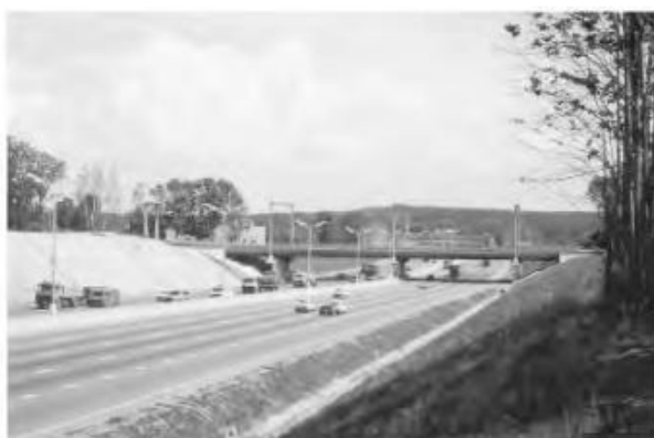
Gambar 5.13 Jembatan Layang Kereta Api Paveletsky.
