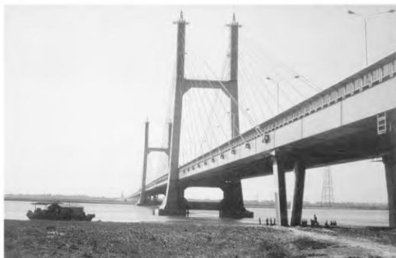
Gambar 2.28 Jembatan Sungai Kuning Dongying.
