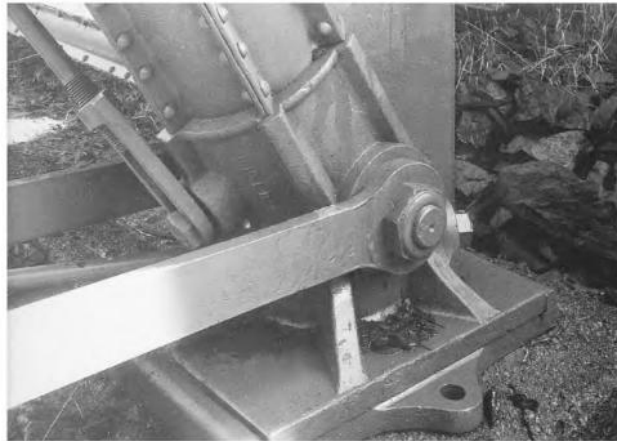
Gambar 6.16 Detail Ini Di Haupt Creek, Di Sonoma County, California, Menunjukkan Sambungan Pin Khas Jembatan Rakitan Dan "Kolom Phoenix," Sebuah Elemen Besi Cor Yang Dipatenkan Dan Dibuat Secara Eksklusif Oleh Phoenix Iron Works Dari Pennsylvania. Jembatan Ini Dibangun Pada Tahun 1880.
