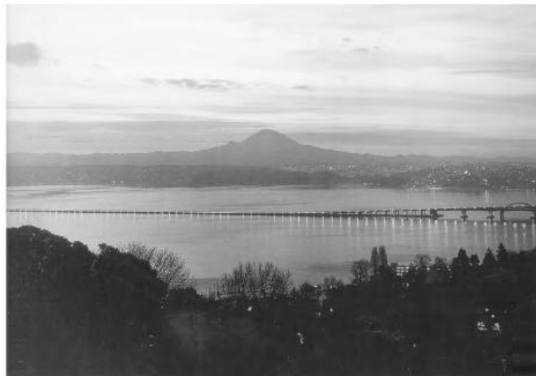
Gambar 6.38 Jembatan Terapung Lacey V. Murrow Sepanjang 2377 M Yang Melintasi Danau Washington Dekat Seattle Terdiri Dari Ponton Beton Berongga. Kedalaman Air, 45,7 M, Menghalangi Pembangunan Tiang Pancang, Tetapi Ada Beberapa Bentang Jembatan Di Atas Perairan Dangkal Dekat Pantai Yang Dapat Dilewati Kapal Kecil. Jembatan Ini Dirancang Oleh Charles Andrew Dan Clark Elkridge Pada Tahun 1940. Jembatan Ini Terdaftar Di Daftar Tempat Bersejarah Nasional.
