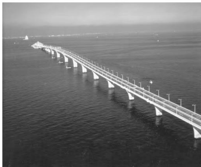
Gambar 4.46 Jembatan Baja Di Tokyo Wan Aqua-Line.
