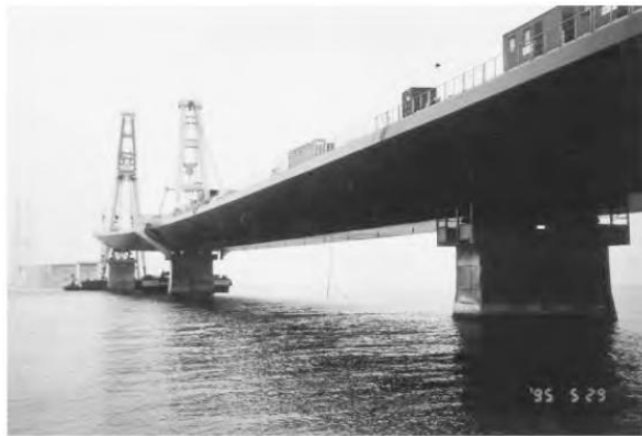
Gambar 3.35 Jembatan Great Belt — Bentang Pendekatan Sepanjang 193 M.
