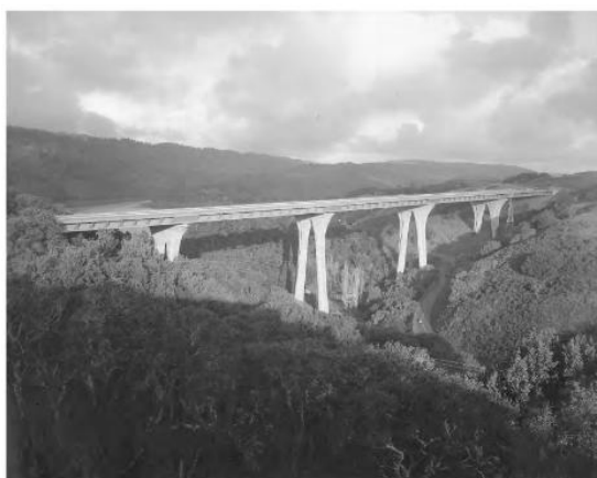
Gambar 6.45 Jembatan Memorial Eugene A. Doran (San Mateo Creek–Crystal Springs Reservoir) Adalah Jembatan Pemenang Penghargaan Yang Terletak Di Lingkungan Taman. Pelat Fasia Eksterior Yang Miring Memberikan Penguatan Web Dan Perlakuan Estetika. Jembatan Balok Baja Pelat Las Ini, Yang Dibangun Pada Tahun 1970, Dirancang Oleh Bob Cassano Dari Divisi Jalan Raya California.
