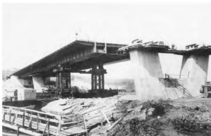
Gambar 5.16 Peluncuran Struktur Atas Untuk Jembatan Sungai Moskva Di Krilatskoe.
