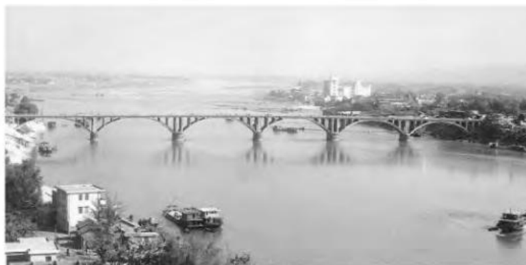
Gambar 2.14 Jembatan Sungai Heyuan Dong.
