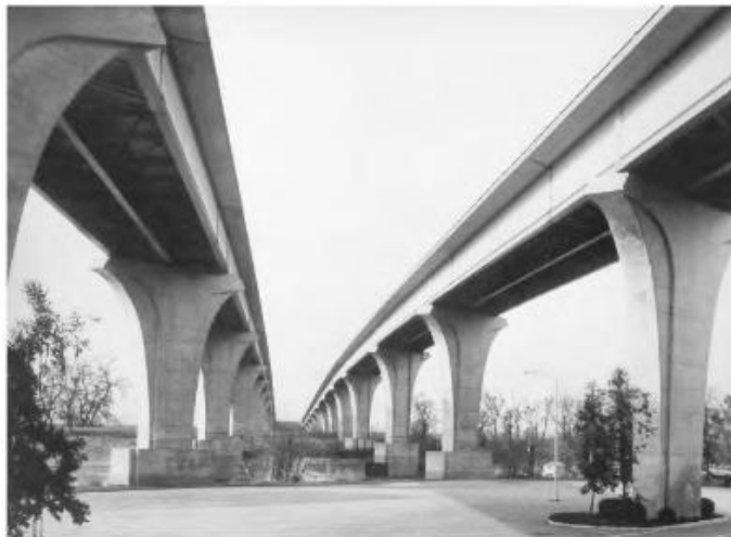
Gambar 6.46 Jembatan Sungai Sacramento Di Elkhorn Adalah Jembatan Balok Baja Yang Menggunakan Baja Berkekuatan Tinggi. Dibangun Pada Tahun 1970 Untuk Jalan Raya Antar Negara Bagian 5, Jembatan Ini Meraih Penghargaan Aisc Pada Tahun Itu. Jembatan Ini Dirancang Oleh Bert Bezzone Dari Divisi Jalan Raya California.
