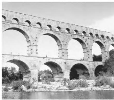
Gambar 3.1 Jembatan Gard Di Atas Sungai Gardon.
