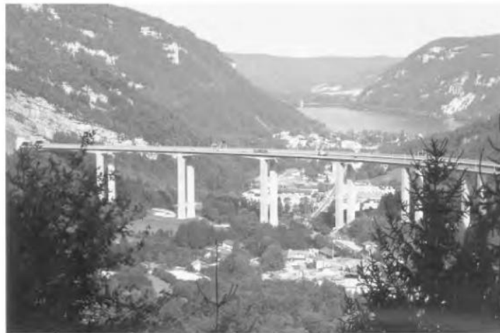
Gambar 3.21 Jembatan Layang Nantua.
