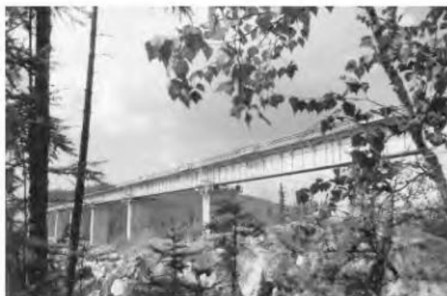
Gambar 5.8 Jembatan Komposit Gelagar Dek Dengan Bentang 55 M Di Atas Sungai Mulmuta (Siberia).
