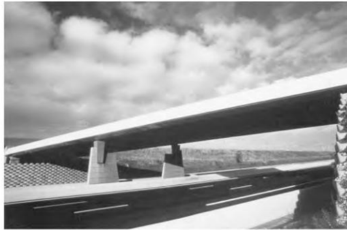
Gambar 3.12 Jembatan Layang Jalan Raya A1.
