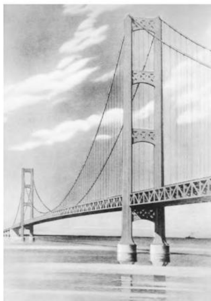
Gambar 6.34 Jembatan Mackinac Straits Adalah Pemenang Penghargaan Jembatan Artistik American Institute Of Steel Construction Tahun 1958 Dan Beberapa Medali Emas. Desainnya Memberikan Tingkat Stabilitas Aerodinamis Yang Belum Pernah Dicapai Sebelumnya Pada Jembatan Gantung. Jembatan Ini Memiliki Bentang Utama 1158 M. Jembatan Ini Dirancang Oleh David Steinman Dan Dimiliki Oleh Mackinac Bridge Authority Di Michigan Utara.
