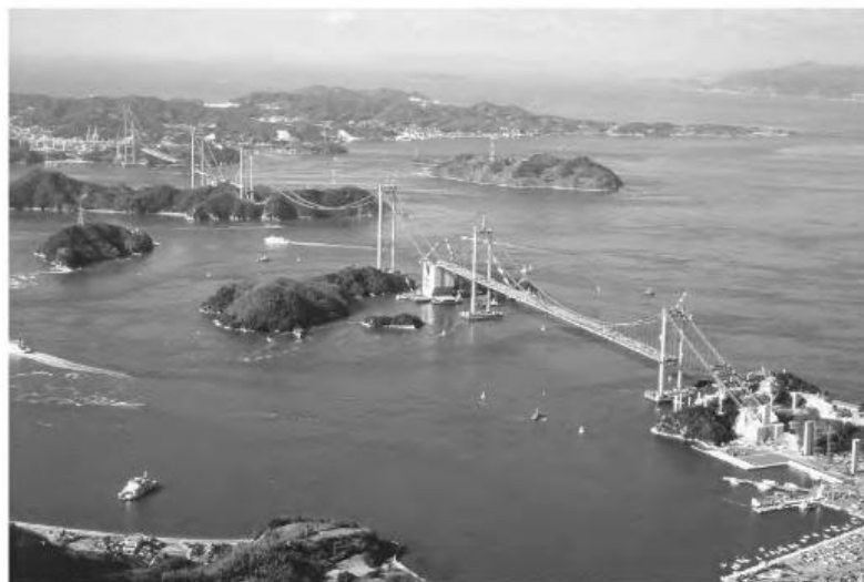
Gambar 4.43 Jembatan Kurushima Kaikyo.
