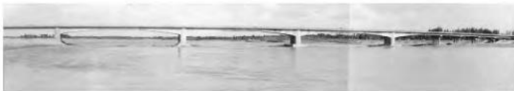
Gambar 2.19 Jembatan Jalan Raya Sungai Kuning Qingtongxia.
