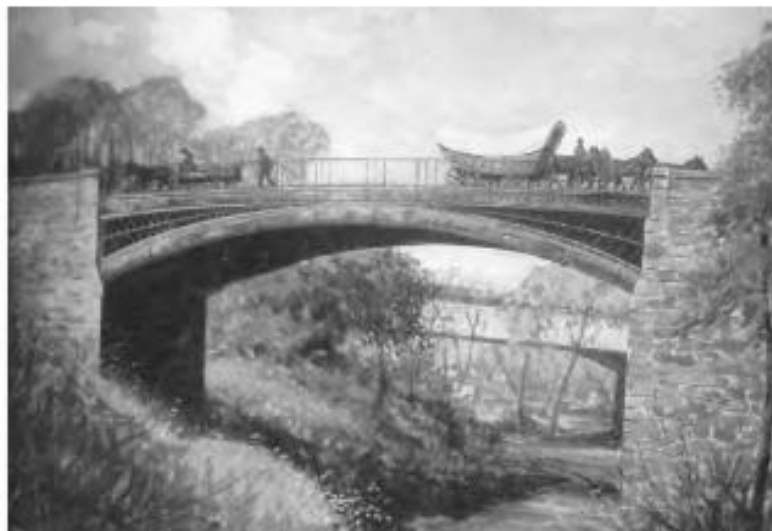
Gambar 6.6 Jembatan Dunlap's Creek, Dibangun Pada Tahun 1839, Adalah Jembatan Besi Pertama Di Amerika Serikat. Jembatan Ini Dibangun Untuk Jalan Nasional Cumberland, Di Brownsville, Pennsylvania, Oleh Kapten Richard Delafield Dari Korps Insinyur Angkatan Darat. Jembatan Ini Masih Digunakan Hingga Saat Ini.
