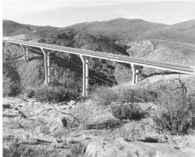
Gambar 6.50 Departemen Transportasi California Bereksperimen Dengan Dan Membangun Satu-Satunya Jembatan Segmentalnya, Di Jalan Raya Antar Negara Bagian 8 Di Atas Pine Valley Di San Diego County Pada Tahun 1974. Bert Bezzone Adalah Insinyur Perancanganya. Jembatan Tersebut Menerima Penghargaan Dari American Society Of Civil Engineers Pada Tahun 1974.
