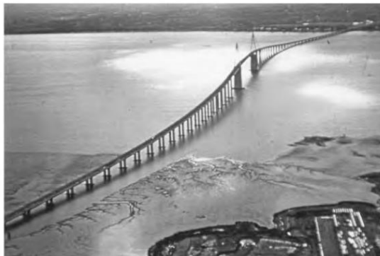
Gambar 3.27 Jembatan Saint Nazaire.
