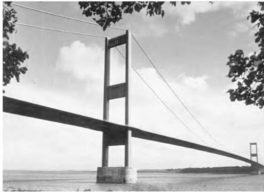
Gambar 3.6 Jembatan Severn Pertama.
