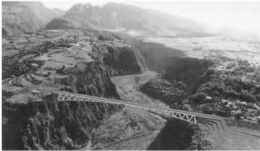
Gambar 3.25 Jembatan Bras De La Plaine.
