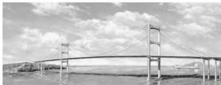
Gambar 2.34 Jembatan Teluk Shantou.
