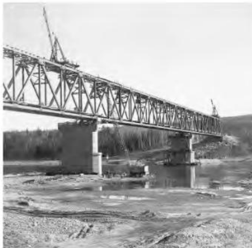
Gambar 5.12 Pemasangan Kantilever Jembatan Rangka Tipikal Menggunakan Derek Derrick.
