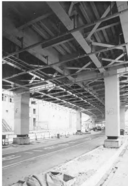
Gambar 4.52 Pilar Rangka Kaku Penampang Benten.
