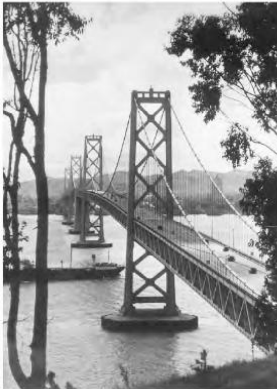
Gambar 6.32 Bentang Barat Jembatan San Francisco–Oakland Bay Sebenarnya Adalah Dua Jembatan Gantung Yang Disambung Ujung Ke Ujung Dengan Jangkar Pusat Di Antara Keduanya. Ini Adalah Satu-Satunya Jembatan Gantung Ganda Di Dunia. Dibuka Pada Tahun 1936, Jembatan Ini Dimiliki Oleh Departemen Transportasi California Dan Dirancang Oleh Pendahulunya, Divisi Jalan Raya California, Charles Andrew, Kepala Insinyur Jembatan.
