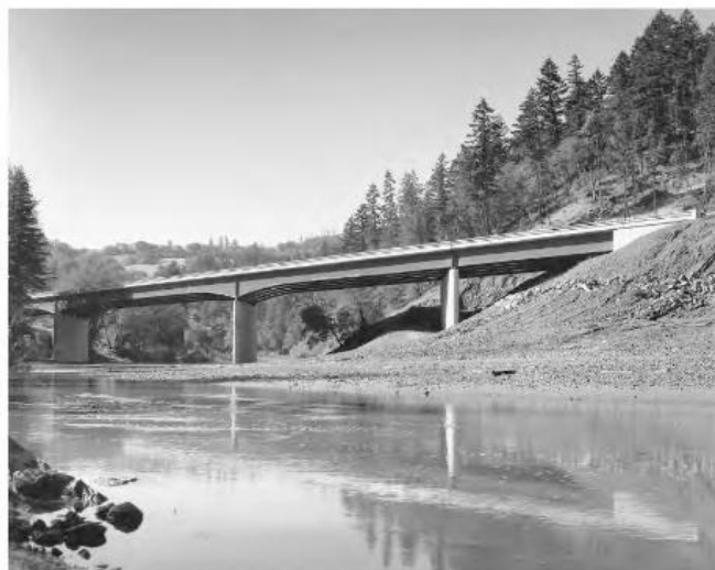
Gambar 6.43 Jembatan South Fork Of The Eel River Di California Utara Merupakan Contoh Keunggulan Struktur Baja Komposit. Jembatan Tahun 1958 Ini Memenangkan Penghargaan Aisc Pada Tahun Tersebut.
