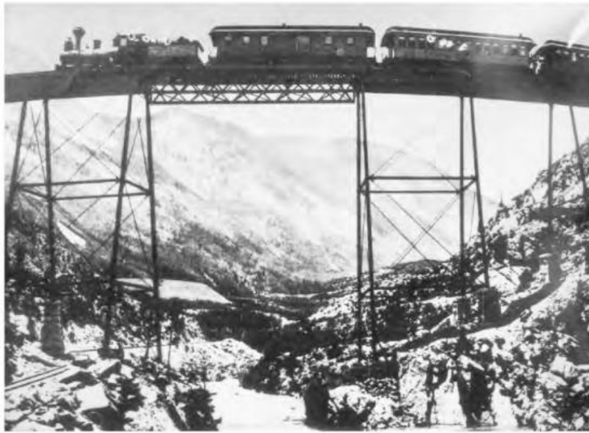
Gambar 6.10 Jembatan Tinggi Devil's Gate Di Georgetown, Colorado, Tampak Terlalu Ramping Untuk Menopang Rel Kereta Api. Namun, Penggunaan Penyeimbang Tegangan Yang Cerdas Mendistribusikan Beban Balik Ke Seluruh Menara. Jembatan Ini Diprefabrikasi Oleh Clark Reeves And Company Dari Phoenixville, Pennsylvania, Untuk Colorado Central Railroad Pada Tahun 1884. Jembatan Ini Terus Digunakan Hingga Dihancurkan Pada Tahun 1939. Replika Yang Dibangun Kembali Pada Tahun 1984 Sekarang Digunakan Oleh Georgetown Loop Mining And Railroad Park.
