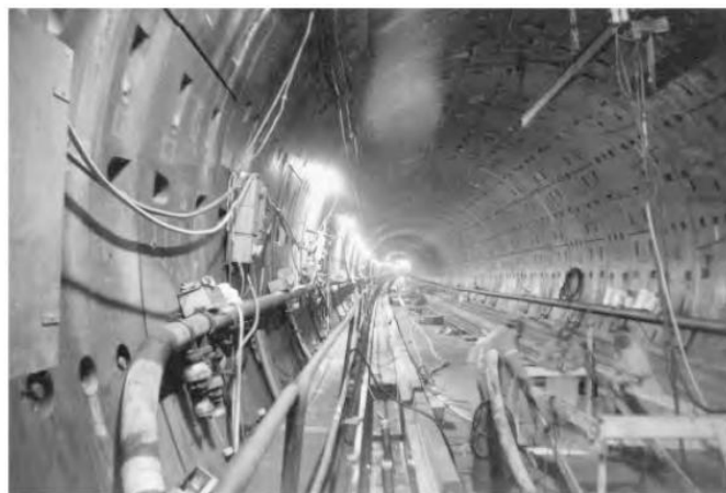
Gambar 3.34 Jembatan Sabuk Besar — Terowongan Kereta Api.
