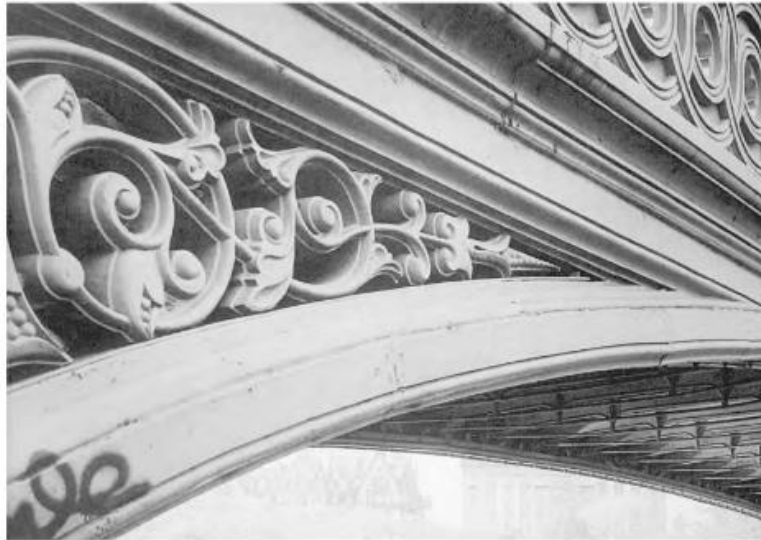
Gambar 6.7 Jembatan Bow Di Central Park, New York, Adalah Jembatan Besi Tempa Tertua Yang Masih Berdiri Di Amerika Serikat, Dibangun Pada Tahun 1818. Jembatan Ini Memiliki Bentang Terpanjang, 26,5 M, Dari Lima Jembatan Berhias Indah Di Taman Tersebut, Yang Semuanya Dirancang Oleh Calvert Vaux Dan Jacob Wrey Mould.
