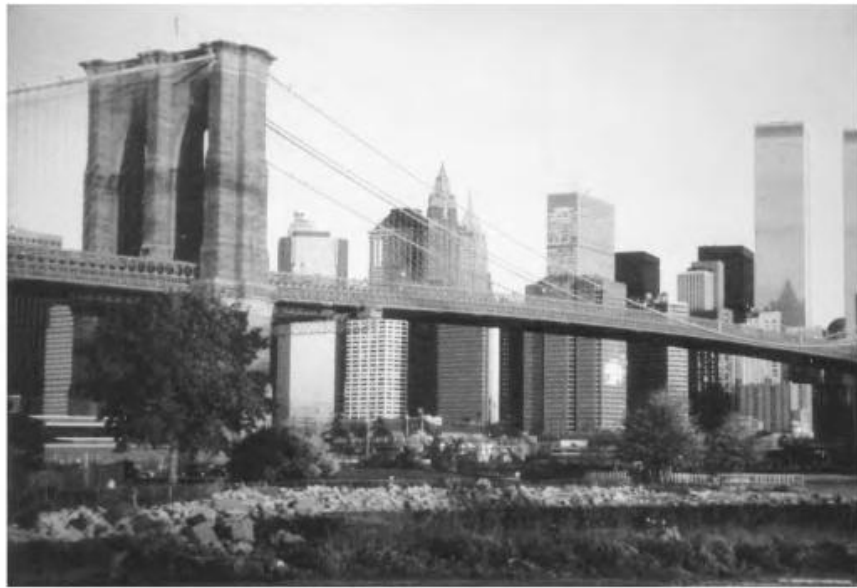
Gambar 6.31 Jembatan Brooklyn Mungkin Merupakan Jembatan Klasik As Yang Paling Terkenal. Ini Adalah Salah Satu Penggunaan Awal Tali Kawat, Karena Merupakan Kombinasi Jembatan Gantung Dan Jembatan Kabel. Dirancang Dan Dibangun Pada Tahun 1883 Oleh John Dan Washington Roebling Untuk Kota New York.
