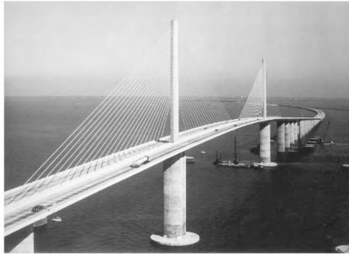
Gambar 6.52 Jembatan Kabel Gantung Sunshine Skyway Yang Baru, Dibangun Pada Tahun 1987, Jelas Merupakan Jembatan Ikonik, Memberikan Pernyataan Yang Cerah Di Atas Pintu Masuk Teluk Tampa, Florida. Struktur Ini Oleh Figg Engineering Menggantikan Rangka Sunshine Skyway Sebelumnya Yang Roboh Akibat Tongkang Yang Melaju Tak Menentu Dan Beratnya Lebih Dari Jembatan Tersebut. Pilar-Pilar Baru Dilindungi Oleh Caisson Yang Sebesar Dan Seberat Tongkang Tersebut.
