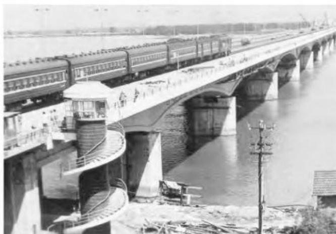
Gambar 2.7 Jembatan Sungai Qiantang Kedua.
