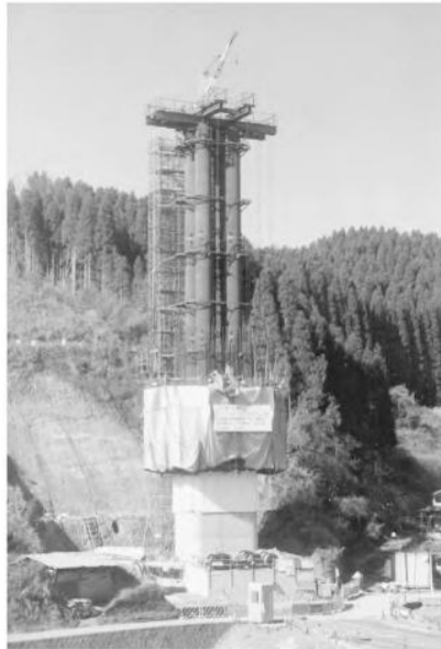
Gambar 4.32 Pilar Jembatan Shigehara.
