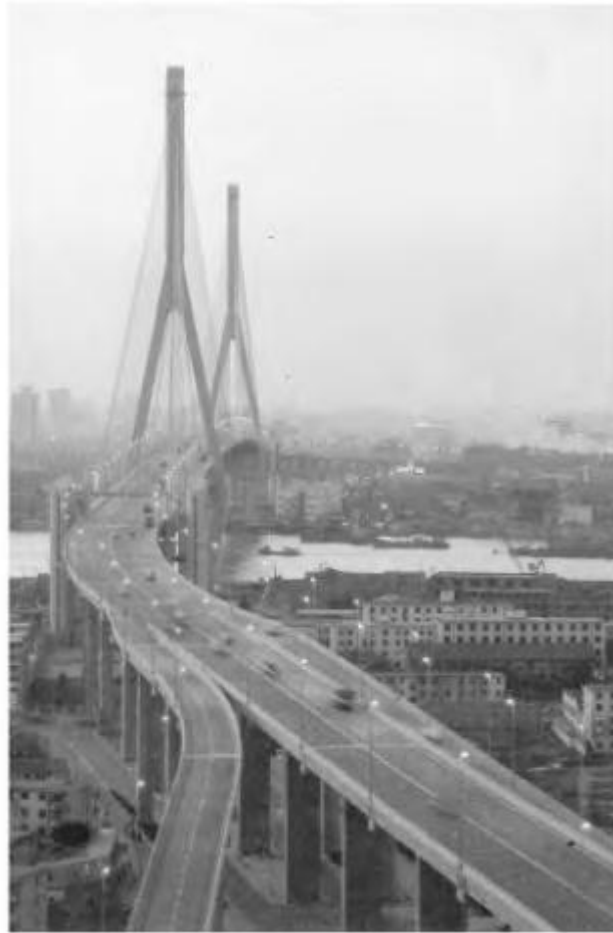
Gambar 2.29 Jembatan Yangpu Shanghai.
