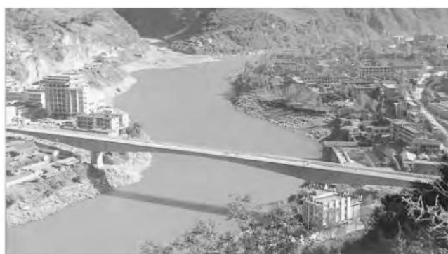
Gambar 2.6 Jembatan Sungai Liuku Nu.
