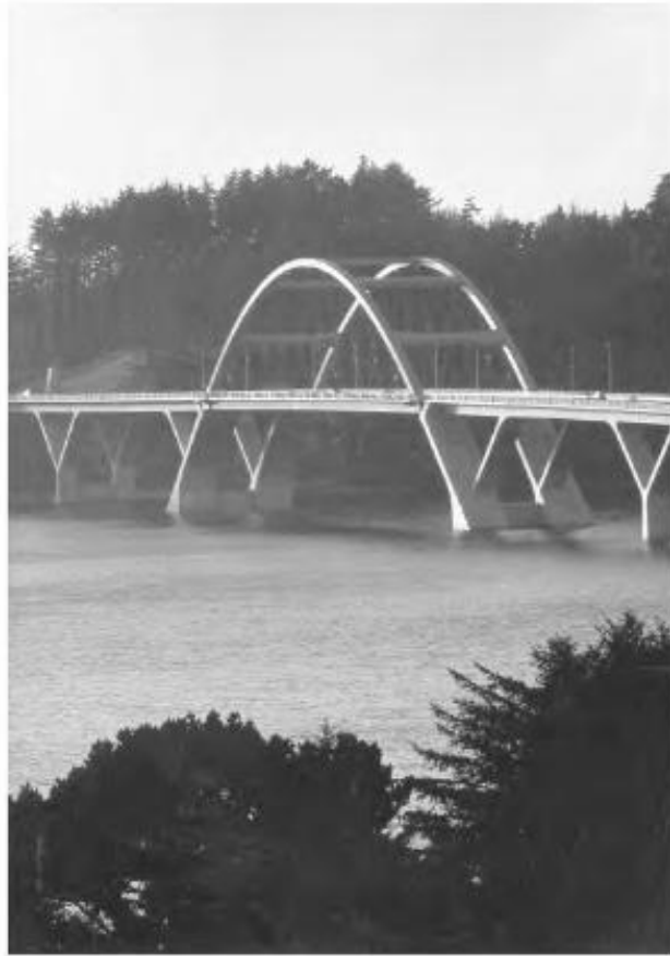
Gambar 6.30 Jembatan Alsea Bay Yang Ikonik Di Waldport, Oregon, Adalah Satu-Satunya Jembatan Conde Mccullough Yang Memerlukan Penggantian Karena Kerusakan. Struktur Baru Ini Mengingatkan Pada Gaya Mccullough Dan Menggunakan Yang Terbaik Dari Dua Bahan Bangunan Paling Populer, Beton Dan Baja. Elemen Baja Yang Dilapisi Beton Disebut Canticrete. Bentang Jembatan Baru Ini, Yang Dibangun Pada Tahun 1992, Dirancang Oleh Howard Needles Tamman Bergendoff. Jembatan Ini Memenangkan Penghargaan Dari American Institute Of Steel Construction Dan Portland Cement Association.
