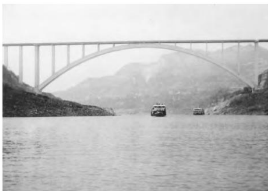
Gambar 2.18 Jembatan Sungai Yangtze Wanxian.
