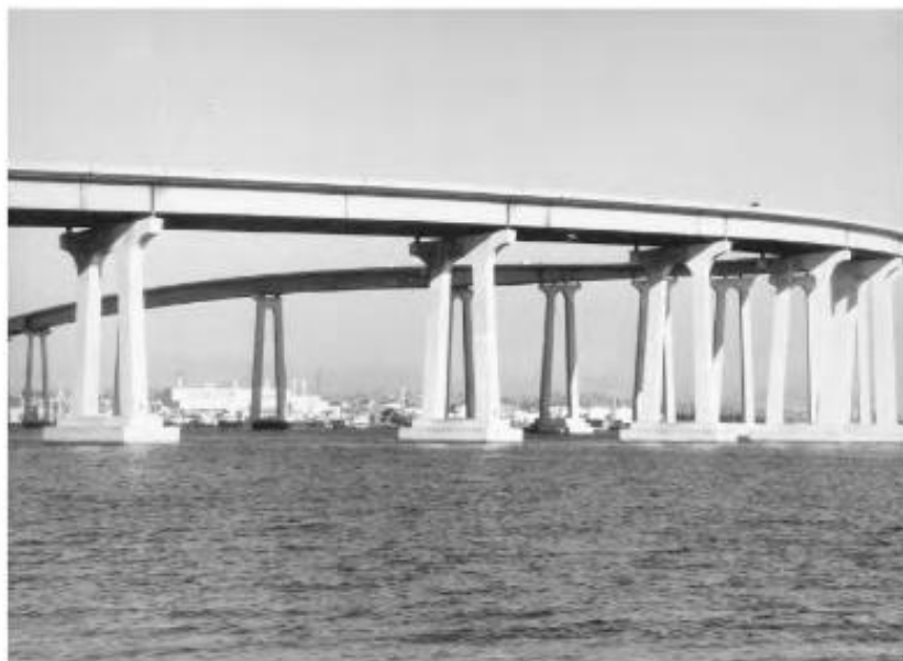
Gambar 6.49 Jembatan Pulau Coronado Di Atas Teluk San Diego Di California Selatan Adalah Jembatan Balok Kotak Baja. Jembatan Ini Memenangkan Penghargaan Aisc Pada Tahun 1970. Jembatan Ini Dirancang Oleh Divisi Penyeberangan Tol Teluk California.
