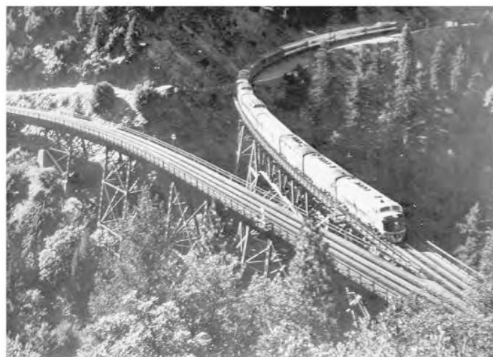
Gambar 6.11 Keddie Wye Adalah Jembatan Menara Baja Unik Yang Dibangun Oleh Union Pacific Railroad Di Ngarai Feather River Yang Terjal Di California Pada Tahun 1912. Jembatan Berbentuk Y Ini Muncul Dari Terowongan Di Dinding Selatan Ngarai Yang Membagi Lalu Lintas Kereta Api Di Atas Sungai; Satu Cabang Menuju Utara Untuk Bertemu Dengan Burlington Northern Railroad Dan Cabang Lainnya Adalah Jalur Utama Yang Menuju Timur Ke Arah Chicago.
