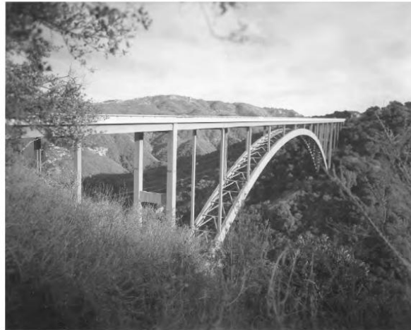
Gambar 6.14 Lengkungan Balok Pelat Baja Cold Springs Canyon, Di Santa Barbara County, California, Adalah Lengkungan Terpanjang Dengan Bentang 213,4 M, Dan Ketinggian 121,9 M. Jembatan Ini Telah Memenangkan Penghargaan Pengelasan Lincoln Foundation, Penghargaan Keindahan American Institute Of Steel Construction, Dan Penghargaan Desain Gubernur. Dibangun Pada Tahun 1963, Jembatan Ini Dirancang Oleh Divisi Jalan Raya California, Marv Shulman, Insinyur Desain.
