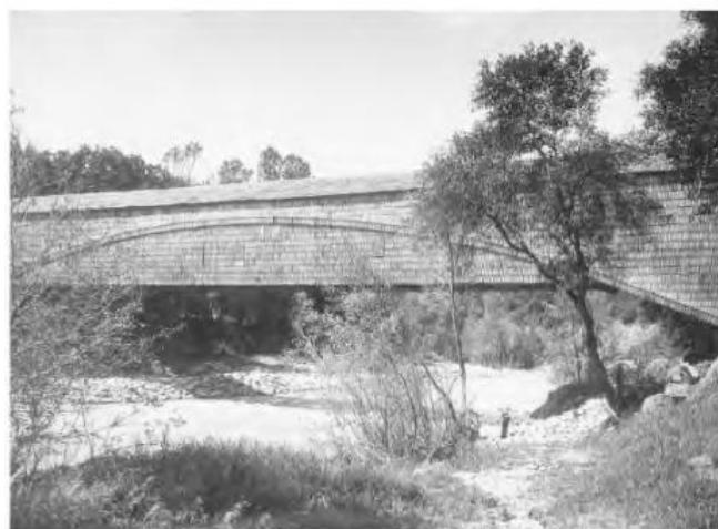
Gambar 6.4 Jembatan Beratap Bridgeport Di California Mungkin Merupakan Jembatan Beratap Bentang Tunggal Terpanjang Di Dunia, Dengan Panjang 70,1 M. Struktur Atasnya Adalah Lengkungan Burr Yang Ditumpangkan Pada Rangka Howe. Jembatan Ini Merupakan Jembatan Tol Yang Dibangun Oleh David Wood Pada Tahun 1862, Dan Kemudian Dibeli Oleh Virginia Turnpike Company.
