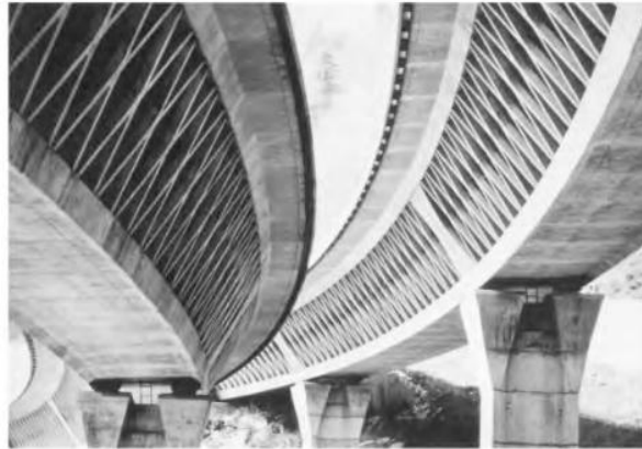
Gambar 3.18 Jembatan Sylans — Dua Dek Paralel.
