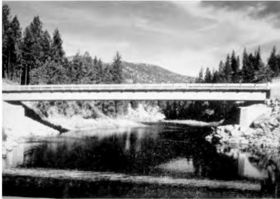
Gambar 6.28 Jembatan Rockcut, Milik Kabupaten Stevens Dan Ferry, Meraih Penghargaan Desain Dari Portland Cement Association Pada Tahun 1997. Perancangnya Adalah Nicholls Engineering.
