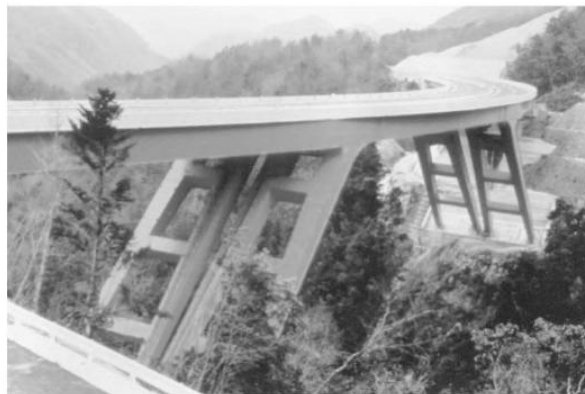
Gambar 4.13 Jembatan Rangka Kaku Berbentuk Khas.
