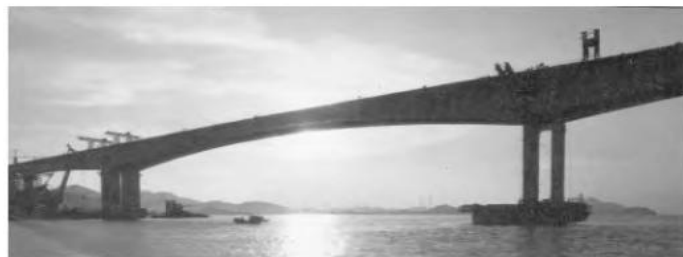
Gambar 2.24 Jembatan Humen (Rangka Kaku Kontinu).
