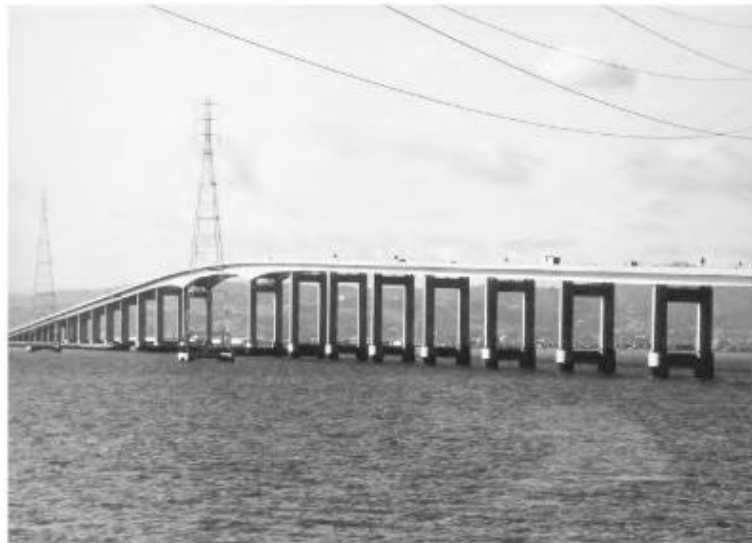
Gambar 6.48 Jembatan San Mateo–Hayward Di Atas Teluk San Francisco, Tidak Hanya Memiliki Bentang Pendekatan Baja Komposit, Tetapi Bentang Utamanya Juga Memiliki Dek Baja Ortotropik. Terdaftar Di Antara Jembatan-Jembatan Yang Istimewa, Jembatan Ini Memenangkan Penghargaan American Institute Of Steel Construction Pada Tahun 1968. Jembatan Ini Dirancang Oleh Divisi Penyeberangan Tol Teluk California.
