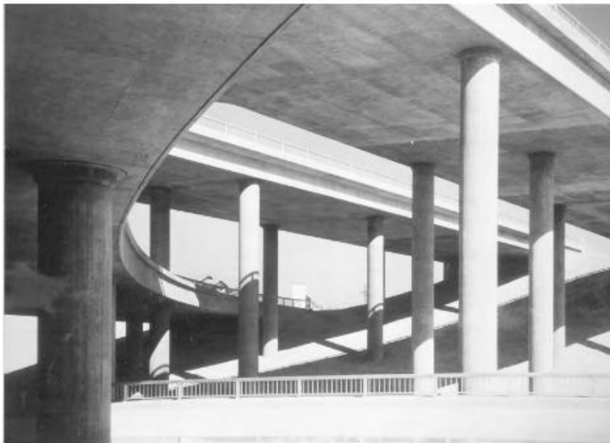
Gambar 6.39 Persimpangan Empat Tingkat Di Pusat Kota Los Angeles, Yang Dibangun Pada Tahun 1950, Adalah Persimpangan Bertingkat Pertama Dari Dua Jalan Bebas Hambatan. Ini Adalah Balok Kotak Beton Bertulang, Tipe Yang Dikembangkan Oleh, Dan Menjadi Ciri Khas, Divisi Jalan Raya California.
