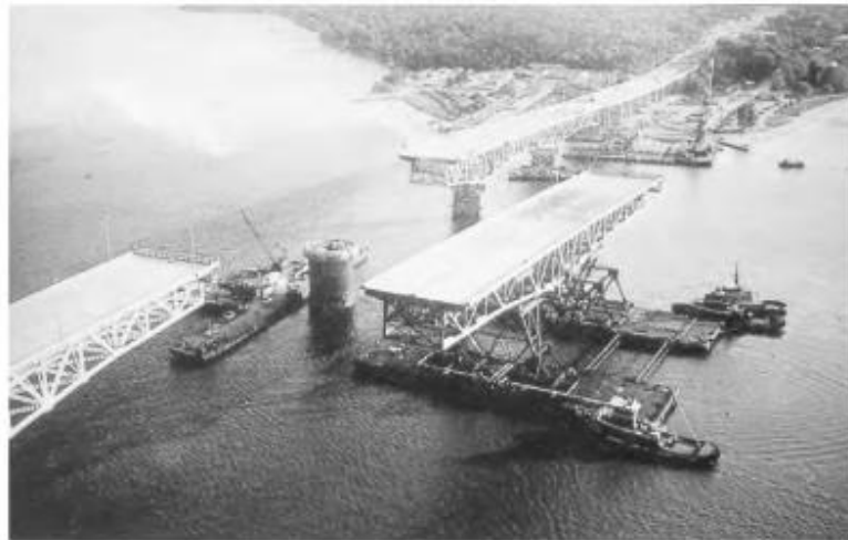
Gambar 6.37 Jembatan George P. Coleman Dengan Bentang Ganda Yang Melintasi Sungai York Di Yorktown, Virginia, Baru-Baru Ini Diperlebar. Untuk Meminimalkan Dampak Pada Arus Lalu Lintas Yang Padat, Bagian Rangka Baru Dibangun Di Dok Kering Dan Diapungkan Ke Tempatnya Saat Bagian Lama Diapungkan Keluar. Jembatan Pengganti Yang Dirancang Oleh Parsons, Brinckerhoff, Quade Dan Douglas Memenangkan Medali George P. Richardson Tahun 1997 Untuk Prestasi Luar Biasa.
