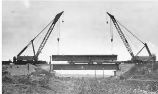
Gambar 5.11 Pemasangan Struktur Kotak Baja Sepanjang 33,6 M Menggunakan Derek Boom.
