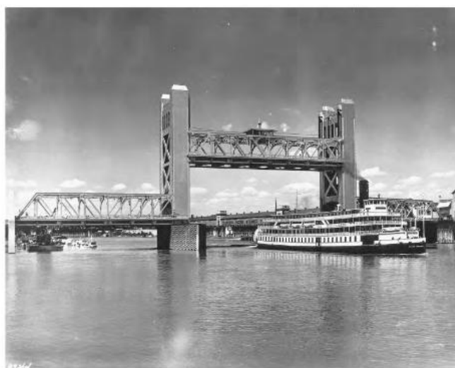
Gambar 6.36 Jembatan Tower Di Sacramento Meraih Penghargaan Desain Aisc Pada Tahun 1936, Tahun Pembangunannya. Bentang Angkat Yang Unik Ini Dilapisi Pelat Baja Untuk Menutupi Bagian-Bagian Yang Bergerak. Jembatan Ini Dirancang Oleh Leonard Hollister Dari Divisi Jalan Raya California.
