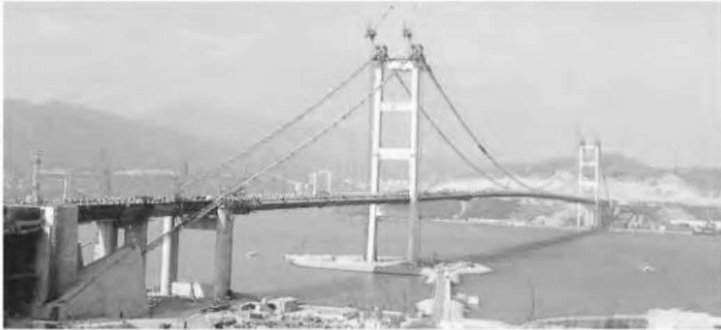
Gambar 2.35 Jembatan Tsing Ma Hong Kong.
