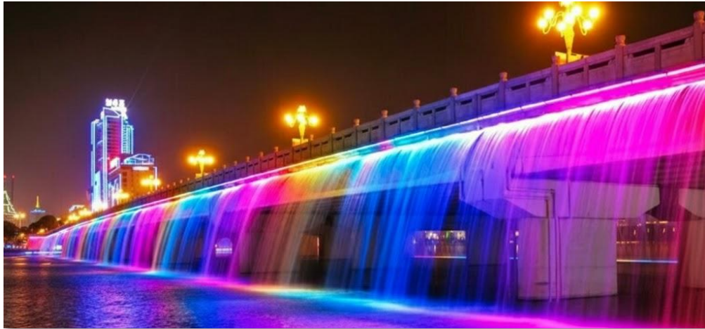
Gambar 1.26 Jembatan Banjir Kanal Barat
