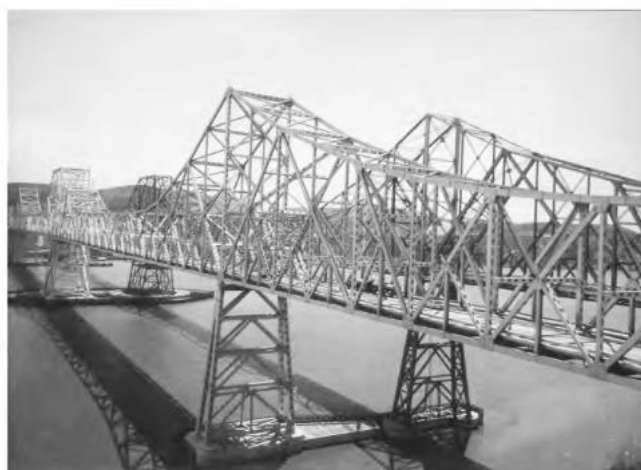
Gambar 6.17 Jembatan Selat Carquinez Di California, Yang Dibangun Oleh American Toll Bridge Company Sebagai Jembatan Tol Swasta Pada Tahun 1927, Adalah Contoh Rangka Kantilever Dengan Elemen Penegang Batang Mata. Jembatan Kembar Paralel Yang Menggunakan Baja Hibrida Berkekuatan Tinggi Yang Dilas Dirancang Dan Dibangun Pada Tahun 1954 Oleh Divisi Jalan Raya California, Roger Sunbury, Seorang Insinyur. Jembatan
