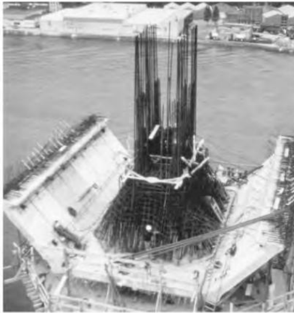
Gambar 3.30 Jembatan Brotonne — Penguatan Dasar Pylon.
