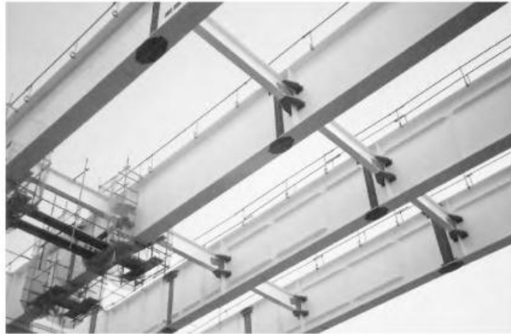
Gambar 4.49 Balok I Pelat Dengan Balok Melintang Sederhana.
