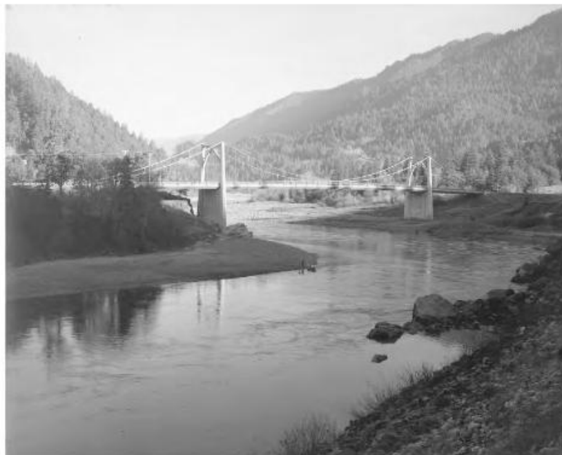
Gambar 6.47 Penyeberangan Sungai Klamath Di Orleans, California Utara, Adalah Pemandangan Indah Di Jalan Terpencil. Terdapat Tujuh Bangunan Di Lokasi Ini, Satu Terbakar Dan Lima Hanyut Terbawa Banjir Besar. Jembatan Gantung Balok Kotak Baja Yang Ada Saat Ini Telah Bertahan Lebih Lama Daripada Pendahulunya. Dibangun Pada Tahun 1967, Jembatan Ini Dirancang Oleh Bert Bezzone Dari Divisi Jalan Raya California.
