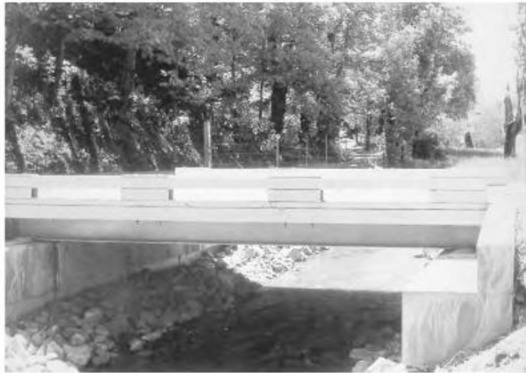
Gambar 6.54 Jembatan Laurel Lick Adalah Jembatan Komposit Kedua Yang Selesai Dibangun. Jembatan Ini Dimiliki Oleh Departemen Jalan Raya Virginia Barat Dan Dibangun Secara Eksperimental Bersama Dengan Universitas Virginia Barat, Pada Tahun 1997.
