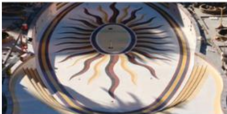
Gambar 7.15 Tangki kolam renang baja tahan karat berlapis mozaik. Hanya perekat epoksi yang dapat digunakan untuk memasang ubin langsung ke tangki baja. (Foto milik Bradford Products, LLC).
