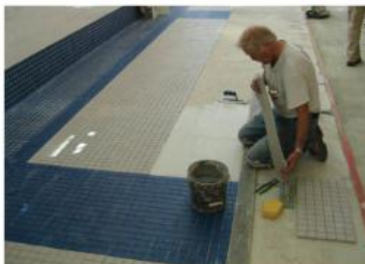
Gambar 11.8 Hanya cukup adukan semen portland tipis yang diperkuat lateks yang dioleskan agar pemasangan mosaik porselen dapat dilakukan dalam waktu kerja adukan yang umum – biasanya 15 menit pada suhu 70°F (21°C).
