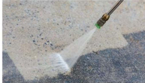
Gambar 6.7 Pencucian air bertekanan tinggi (penyemprotan air) dapat menghilangkan jumlah beton yang terkontaminasi yang dibutuhkan.
