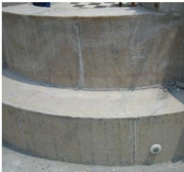
Gambar 3.4 Cangkang kolam renang fiberglass menunggu pemasangan ubin.
