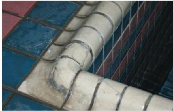
Gambar 7.6 Tepi kolam/dek berbentuk unik yang membutuhkan pembentukan plester yang cermat agar ubin yang sudah jadi dapat dipasang.
