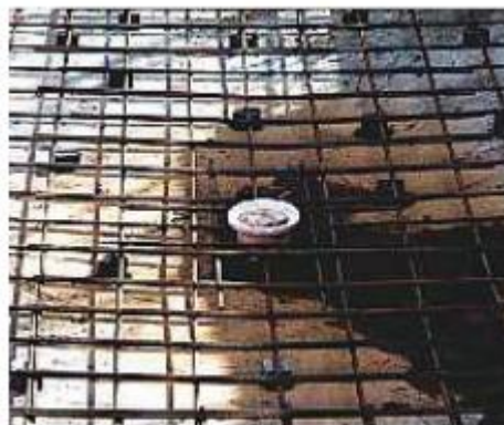
Gambar 4.5 Posisi saluran pembuangan dan tulangan baja tipikal sebelum aplikasi beton gunit.
