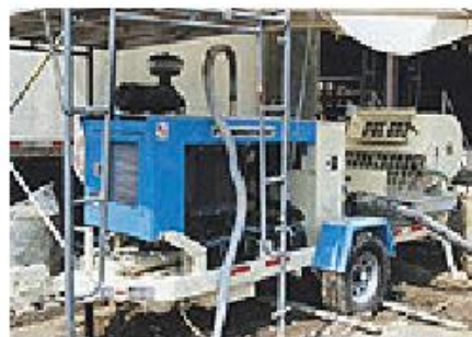
Gambar 6.18 Mortar dicampur dan dipompa ke area dalam kombinasi mixer/pompa mortar.
