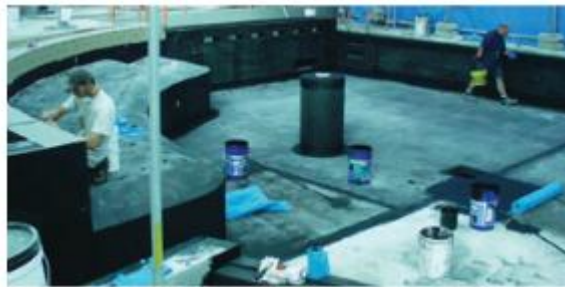
Gambar 7.9 Tampilan skala penuh membran kedap air cair pada proyek kolam renang skala besar.
