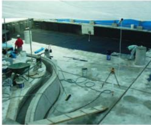
Gambar 11.1 Aplikasi eksterior harus dilindungi dari cuaca selama periode instalasi dan pengeringan material instalasi. Tenda sementara didirikan di atas kolam renang ini untuk melindungi aplikasi dari sinar matahari langsung, angin, dan hujan.
