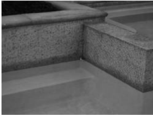
Gambar 11.14 Perhatikan perbedaan warna antara ubin dan nat di atas garis air dan di bawah garis air. Kondisi ini umum terjadi karena nat berbahan dasar semen menyerap air dan menciptakan tampilan yang lebih gelap di garis air. Ekspektasi harus dikelola sesuai dengan hal tersebut.
