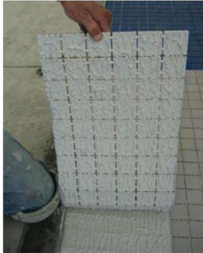
Gambar 11.9 Merupakan praktik yang baik untuk secara berkala mengangkat/melepas ubin atau batu yang baru dipasang untuk memverifikasi bahwa minimal 95% mortar perekat kontinu telah tercapai. Jika cakupan yang diinginkan tidak tercapai, gunakan sekop yang lebih besar untuk mengeluarkan mortar perekat yang cukup dan pukul ubin dengan benar untuk mencapai hasil yang diinginkan.
