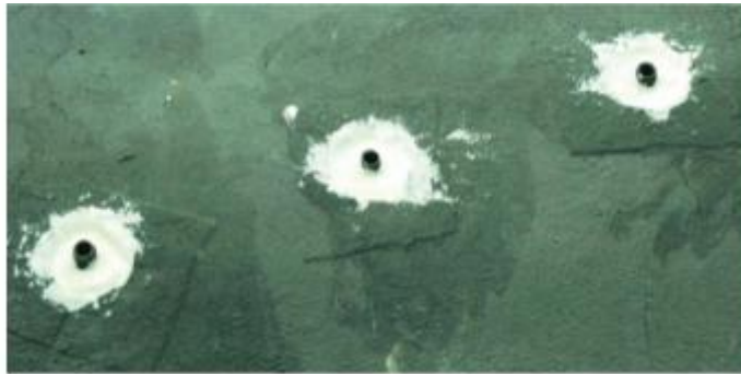
Gambar 7.7 Membran kedap air epoksi diaplikasikan pada lubang penetrasi pipa di atas membran kedap air cair yang telah mengering untuk memastikan penyegelan sempurna pada lubang penetrasi.
