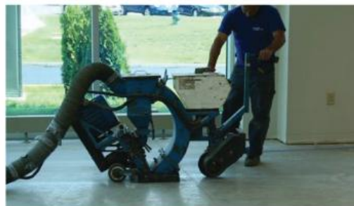
Gambar 6.6 Penyemprotan pasir sangat ideal untuk area di luar tangki kolam renang dan fitur air, serta untuk area di mana akses oleh peralatan tidak menjadi masalah.
