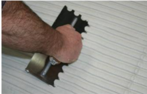
Gambar 7.1 Mortar ubin besar dan berat diaplikasikan dengan sekop bergerigi 3/4" (19 mm).
