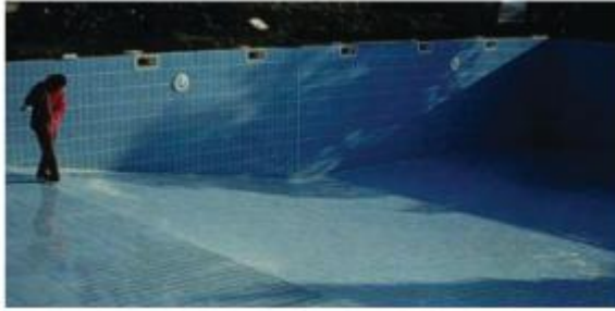
Gambar 7.19 Tampilan kolam renang yang telah selesai. Perhatikan sambungan pergerakan pada perubahan bidang di dasar kolam dan sambungan pergerakan lapangan lainnya di dinding dan lantai.
