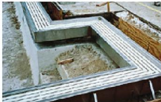
Gambar 7.5 Rakitan Talang Kolam Renang dari Baja Tahan Karat. Ubin atau Batu dibawa ke rakitan talang di dalam tangki dan di dek (Foto milik Barrier Lining, Inc.)
