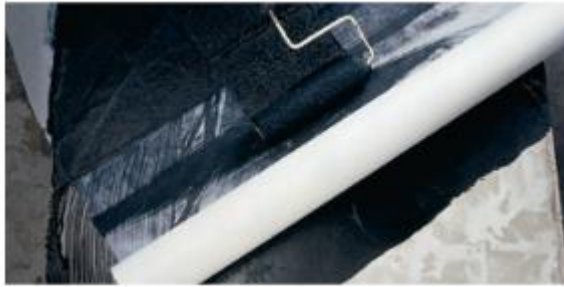
Gambar 7.8 Membran cair yang diaplikasikan pada substrat beton.
