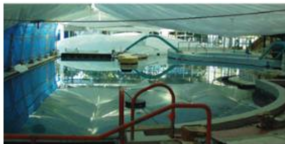
Gambar 7.12 Tangki kolam renang diisi dengan air selama tahap uji banjir. Setelah uji banjir berhasil, kolam akan dikeringkan dan siap untuk dipasang ubin (sebagai catatan tambahan, perhatikan tenda yang melindungi fitur air dari cuaca selama proses pemasangan dan pengeringan).
