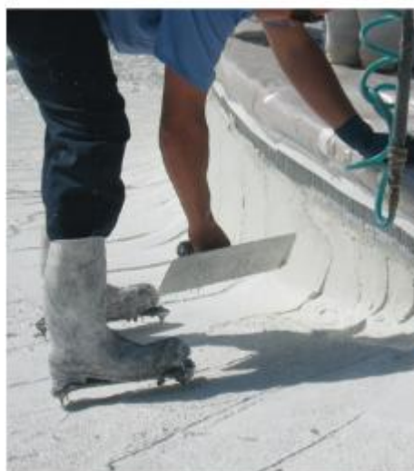
Gambar 5.10 Instalasi plester Marcite tipikal (perhatikan sepatu berduri).
