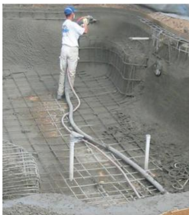
Gambar 3.1 Penyemprotan dan penyelesaian Guniting pada kolam renang perumahan.
