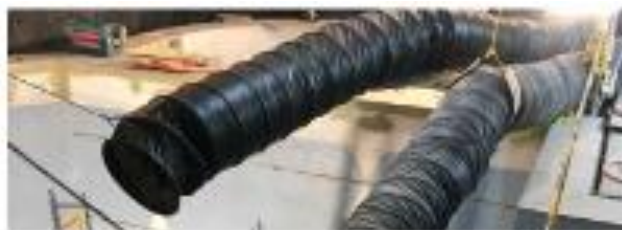
Gambar 6.2 Pekerjaan kolam renang luar ruangan yang dilakukan dengan tenda dan saluran pemanas untuk mengatur suhu.
