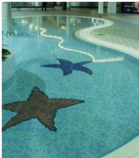
Gambar 4.1 Kolam renang dangkal taman air dalam ruangan dengan sambungan pergerakan yang terdefinisi dengan jelas.
