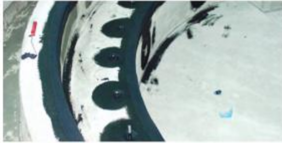
Gambar 7.10 Detail perlakuan penetrasi pipa pada aplikasi kolam renang ini.
