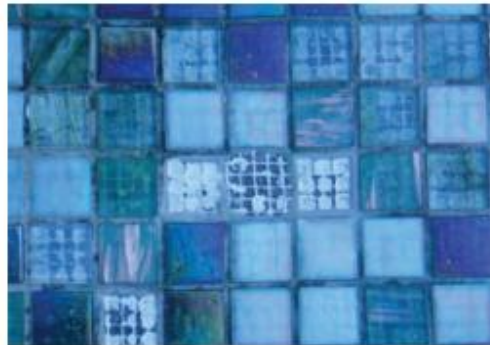
Gambar 11.10 Efek ubin kaca yang dipasang pada jaring menggunakan perekat dan jaring yang tidak cocok untuk perendaman terus menerus. Perekat telah mengembang dan kehilangan daya rekat ke bab belakang ubin.
