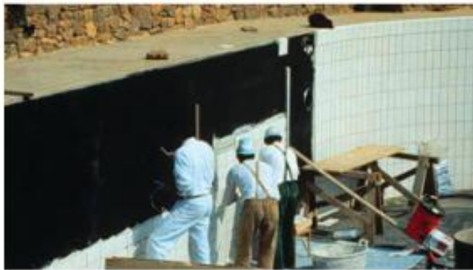
Gambar 7.13 Pemasangan ubin mosaik dengan mortar tipis semen Portland yang diperkuat lateks cair.
