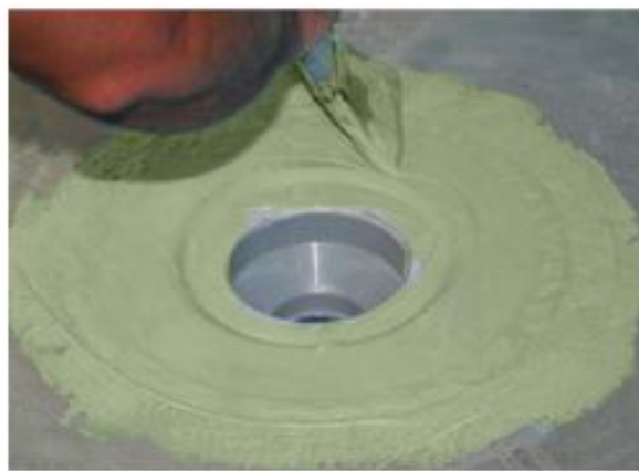
Gambar 11.4 Membran kedap air cair harus dipasang dengan cara dijepit ke dalam saluran pembuangan tipe penjepit dua bab untuk menciptakan segel kedap air.
