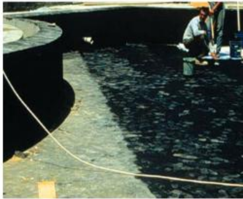
Gambar 11.3 Setelah membran kedap air diaplikasikan, membran tersebut harus dilindungi dari lalu lintas dan pekerjaan dari tukang lain.
