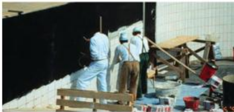
Gambar 7.14 Pemasangan ubin porselen berlapis glasir dengan mortar tipis semen Portland yang diperkuat lateks cair di atas membran kedap air yang diaplikasikan secara cair.
