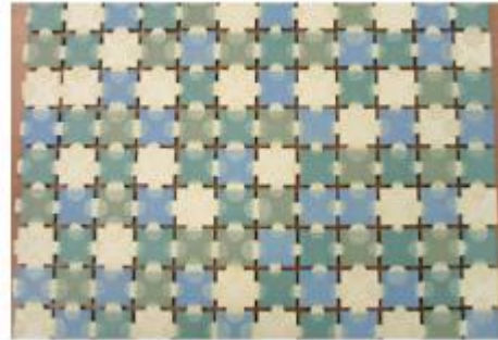
Gambar 5.6 Contoh ubin yang dipasang dengan titik PVC.
