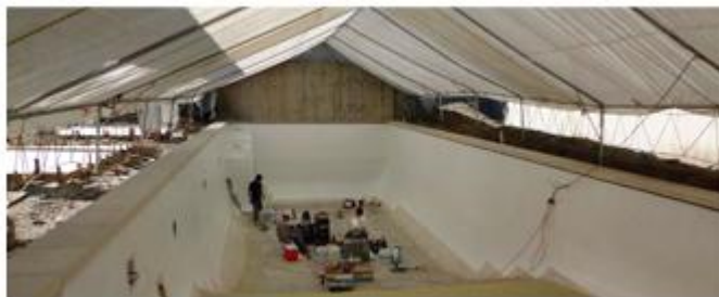
Gambar 6.3 Pekerjaan kolam renang luar ruangan yang dilakukan dengan tenda untuk mengatur suhu.
