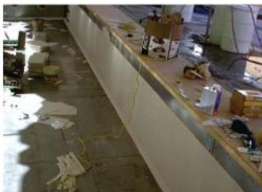
Gambar 11.5 Tangki kolam renang baja. Ubin mosaik porselen dipasang dengan perekat mortar tipis epoksi 100% padat (misalnya Perekat Epoksi LATAPOXY® 300) untuk mencapai ikatan yang sesuai dengan rakitan tangki baja.
