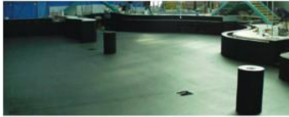
Gambar 7.11 Tangki kolam renang yang kedap air sedang dalam proses pengeringan dan menunggu uji banjir. Masa pengeringan membran kedap air dapat bervariasi tergantung produsen. Konsultasikan dengan produsen bahan kedap air untuk informasi detail tentang laju pengeringan dan proses uji banjir.
