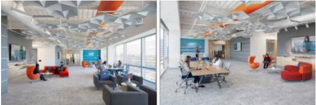
Gambar 3.7 Kantor pusat GlobalLogic, Santa Clara (CA), AS. Langit-langit dilengkapi dengan panel penyerap suara geometris yang menyebarkan dan menyerap gelombang suara, mengurangi gema. Material lantai yang lembut, termasuk ubin karpet, semakin meredam kebisingan sekitar dengan meminimalkan transmisi suara dari langkah kaki dan gerakan. Tempat duduk berlapis kain yang tersebar di seluruh ruangan menambah penyerapan lokal, menciptakan zona akustik kecil untuk percakapan atau pekerjaan yang terfokus. Perlakuan berlapis ini mengurangi kebisingan latar belakang dan membantu menyeimbangkan stimulasi pendengaran di seluruh area lounge dan kolaborasi.
