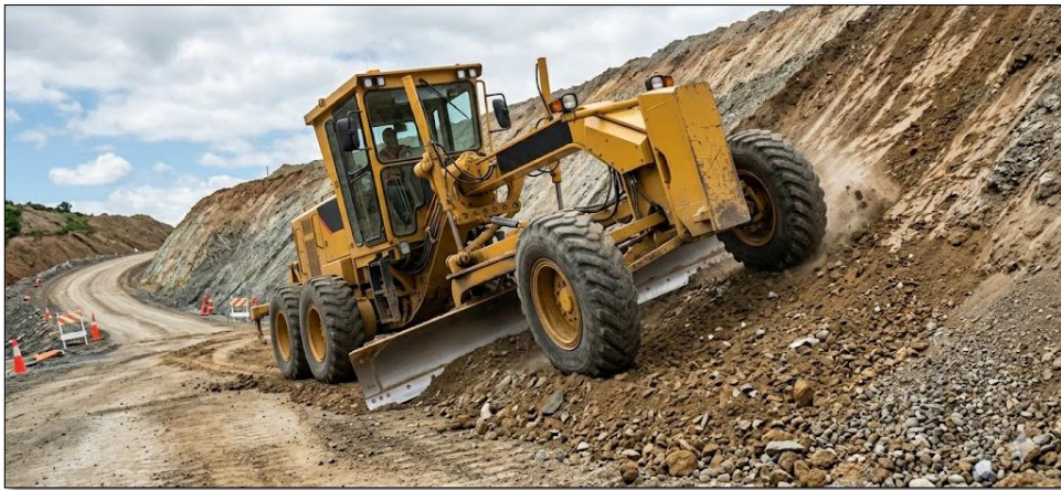
Gambar 7.4 Foto Operasional Motor Grader Melakukan Bank Shaping Pada Tebing Jalan
