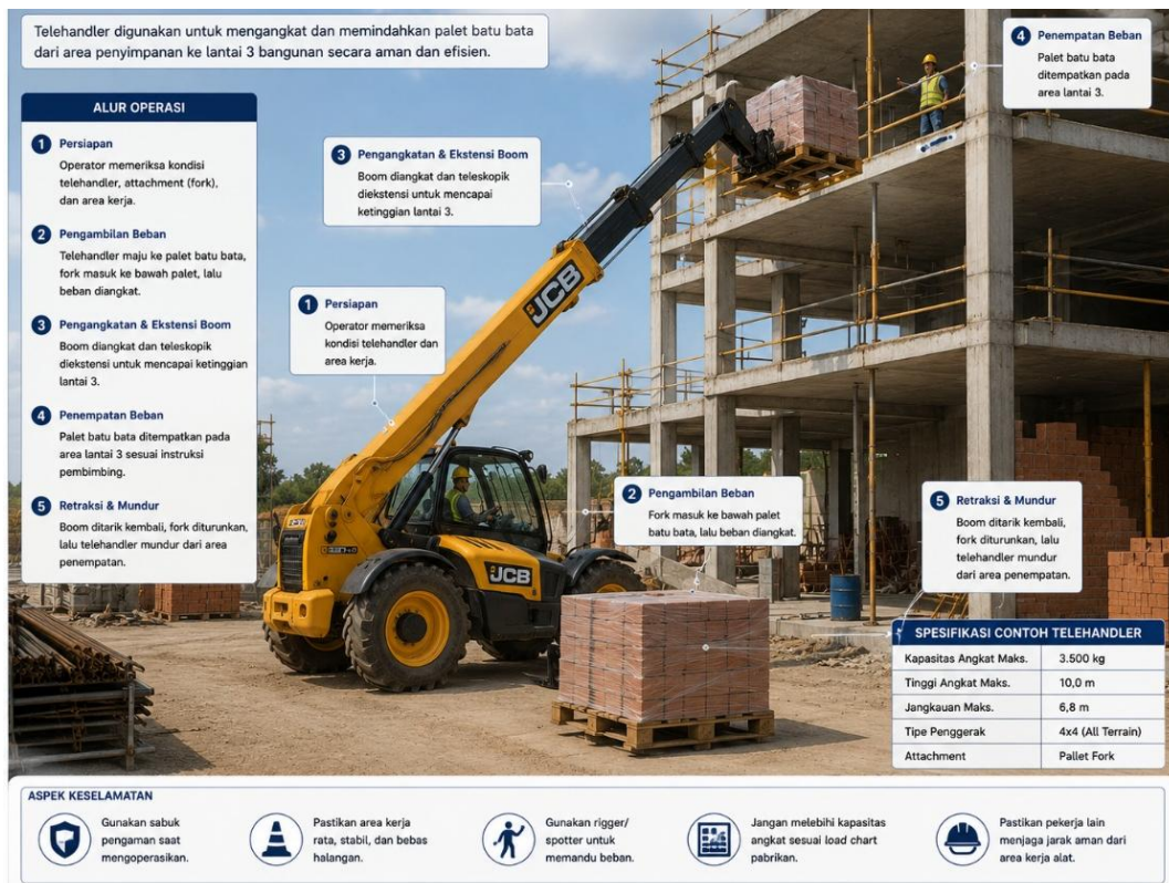
Gambar 9.8 Operasi Telehandler Mengangkat Palet Batu Bata ke Lantai 3 Gedung
