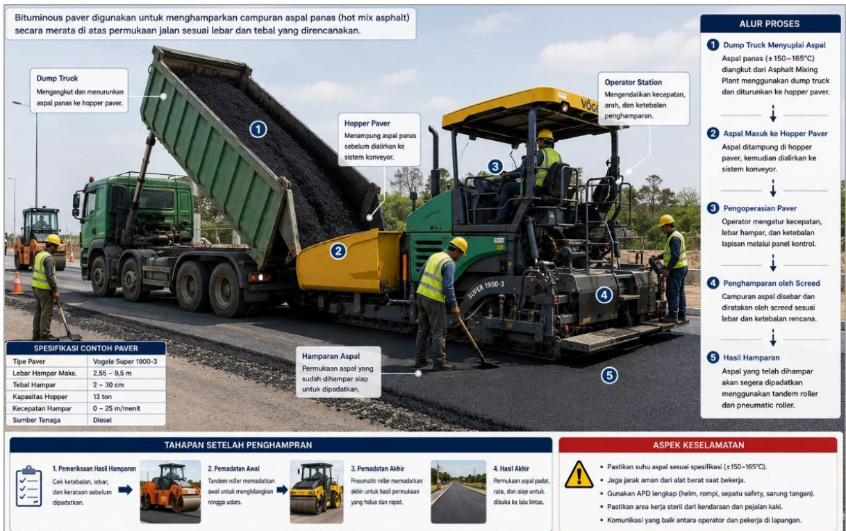
Gambar 9.10 Penggunaan Bituminous Paver Yang menerima Aspal dari Dump Truck
