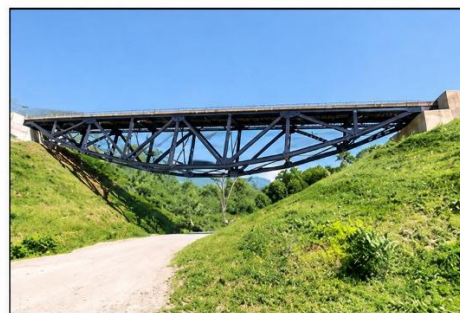
(b) Jembatan Truss Parker Terbalik
