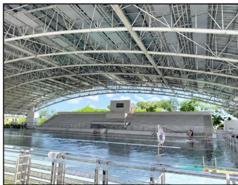
(a) Truss Atap Bentang Lebar Gedung Olahraga
