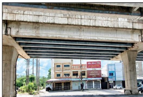
(a) Gelagar Jembatan Dudukan Sederhana
